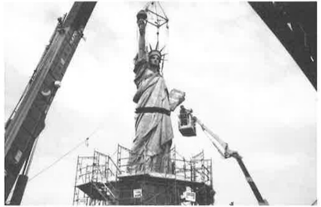
写真-5 設置風景
