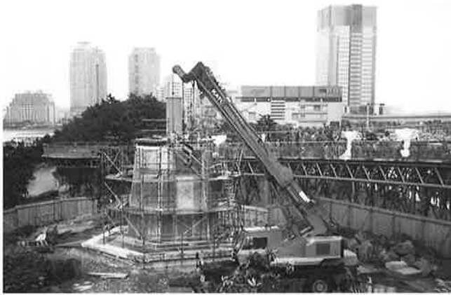
写真-2 台座の施工
