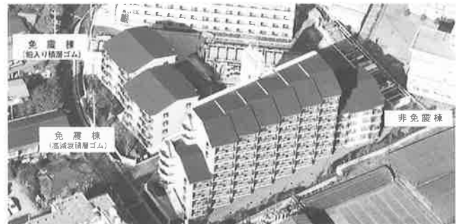
写真-1 免震構法を採用した集合住宅
