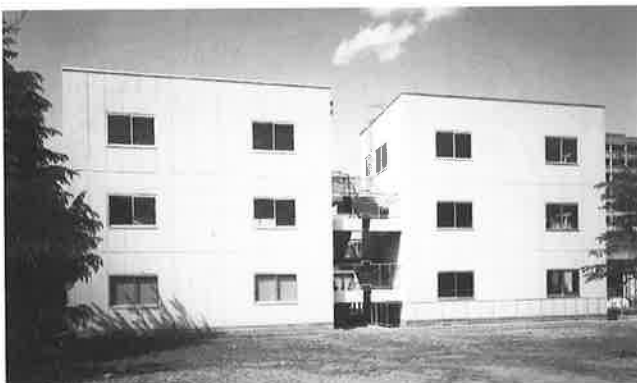
写真 試験建屋全景（左：在来構法、右：免震構法）
