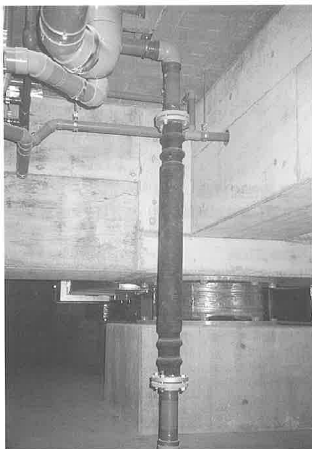
写真-13 Vシステム ゴム製継手 (高圧配管用)
