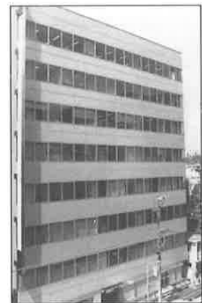
オフィスビル/ブリヂストン虎ノ門ビル
