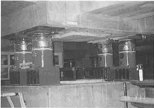
写真-2 既存躯体柱切断状況
