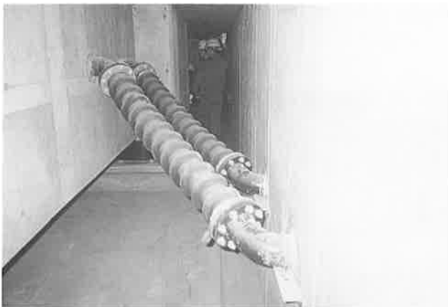
写真-15 Vシステム ゴム製継手 (斜め型取付用)
