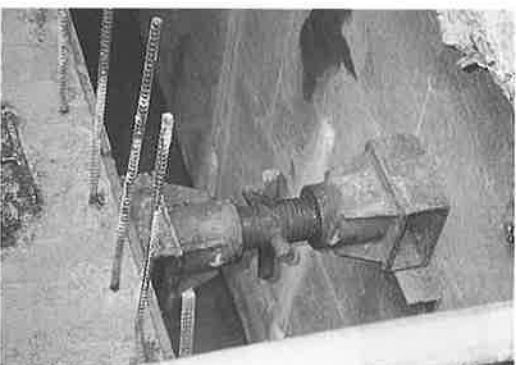
写真-4 ピット部の切梁補強
