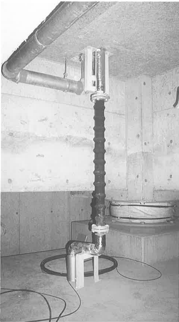
写真-14 Vシステム ゴム製継手 (低圧配管用)
