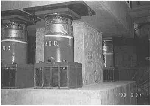
写真-1 ジャッキアップ状況
