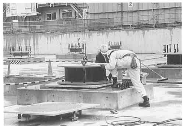
写真-2 取り付け工程
