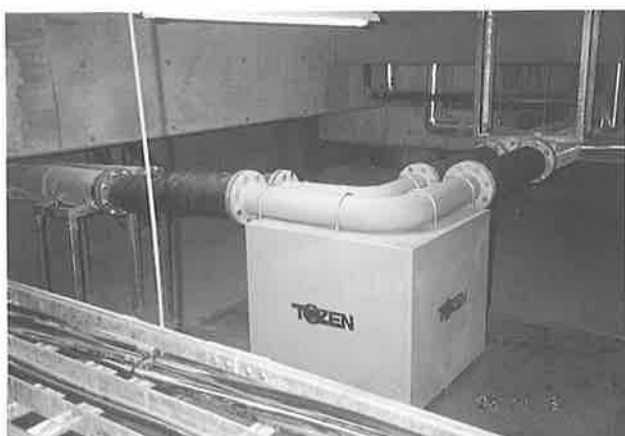
写真-9 Cシステム ゴム製継手 (複数ライン支持)
