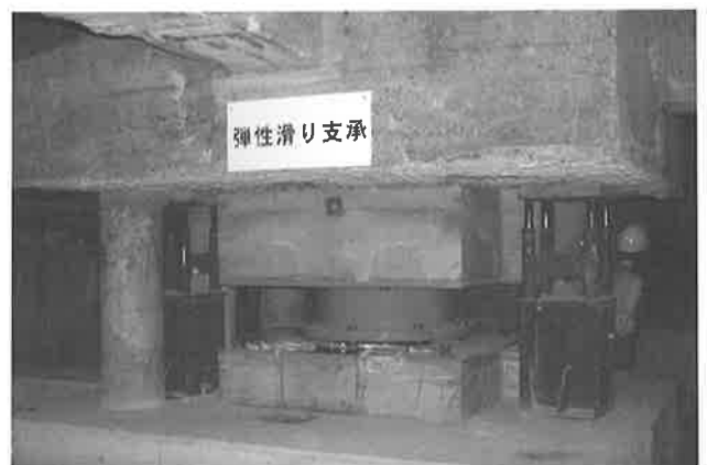
写真-3 設置された弾性すべり支承
