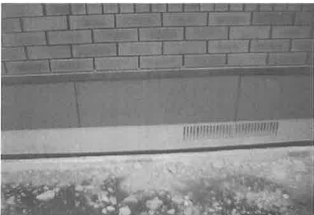
h) 基礎立ち上げ部分
