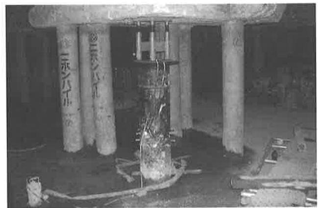
写真-2 掘削された既存杭と圧入された鋼管杭
