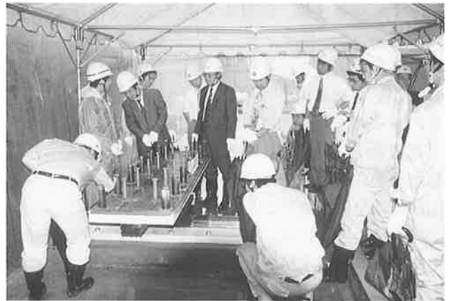
写真-2 現場説明状況
