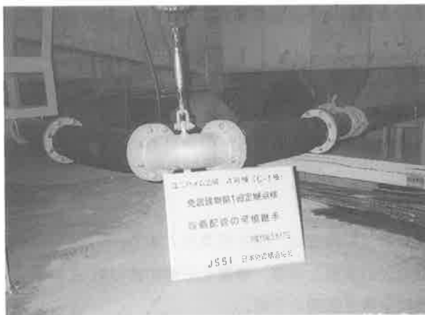
設備配管の可撓継手状況
