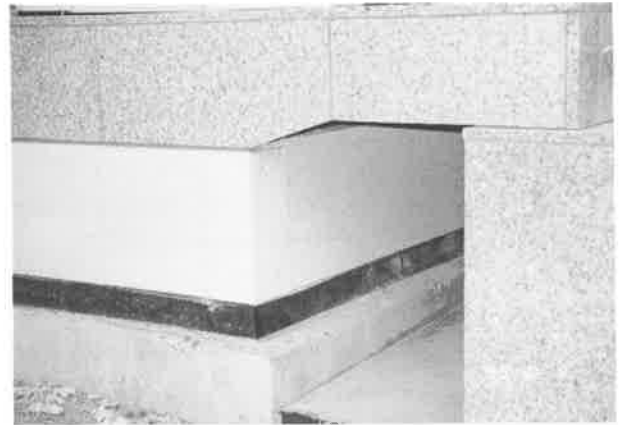
写真-7 階段部納まり(詳細)
