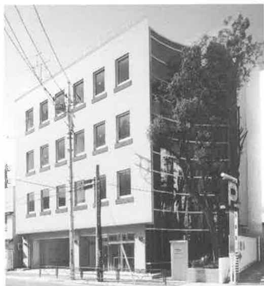
写真—1 建物全景
