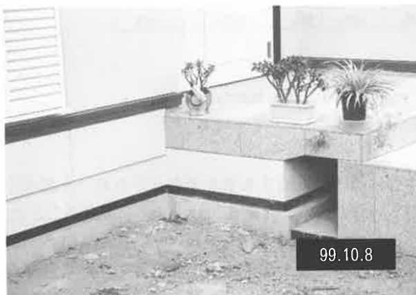
写真-6 階段部納まり
