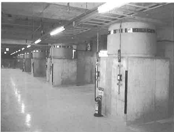
写真5 耐火被覆取り付け事例
