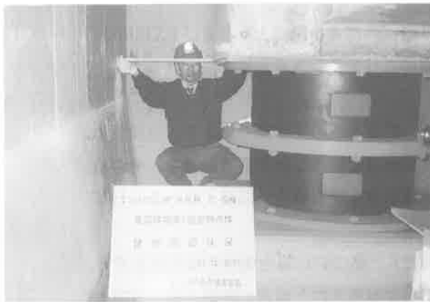
建物クリアランス測定
