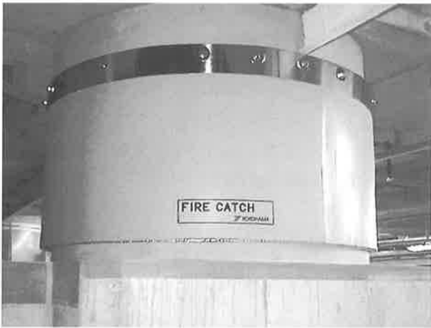
写真4 耐火被覆外観
