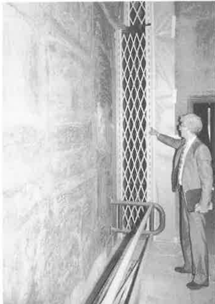
水平動を吸収するためのバッファー（地下階）
