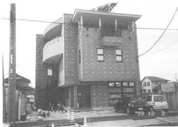
写真-1 吉野ビル外観
