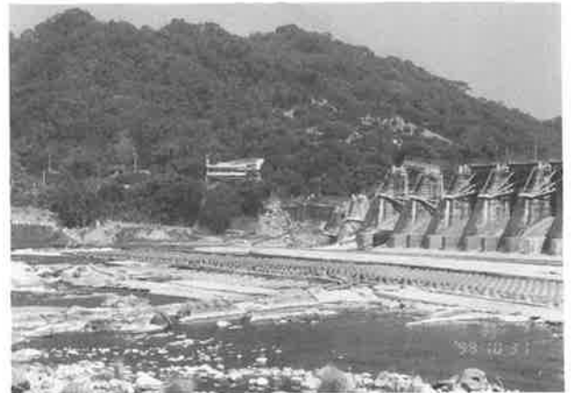
写真一19 台中県石岡郷 石岡ダム 左側が元の高さで、川の部分が約8m隆起した
