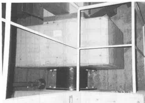
写真-3 免震部材の設置状況
