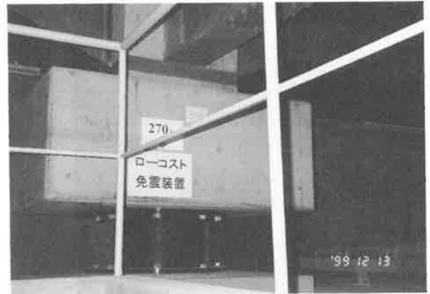
写真-4 免震部材の設置状況 (中国製のローコスト免震部材)
