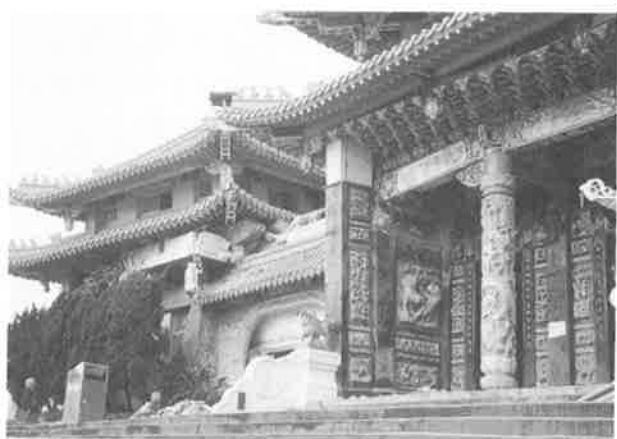
写真一10 中門左側棟2階部分の崩壊
