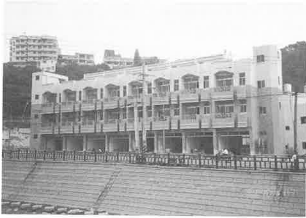
写真一21・22 断層の下側約100mに位置した建物、被害は見られない。
