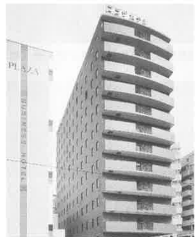
写真-1 建物外観
