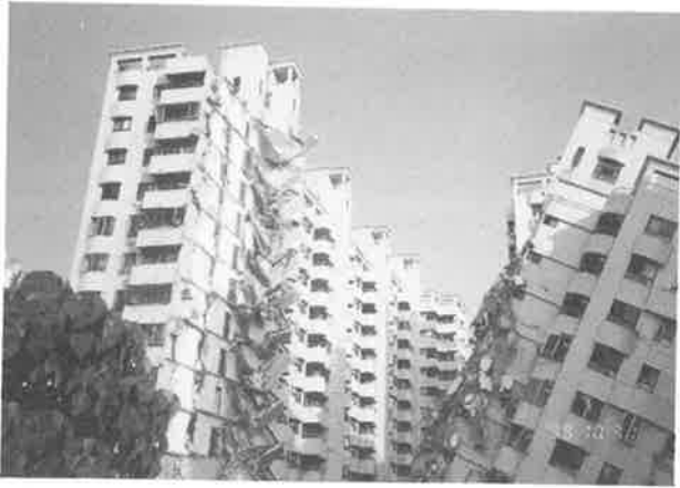
写真一32 台中県大里市 共同住宅RC地上12階地下1階 右側に傾斜している建物は地震前左側と一体であった。
