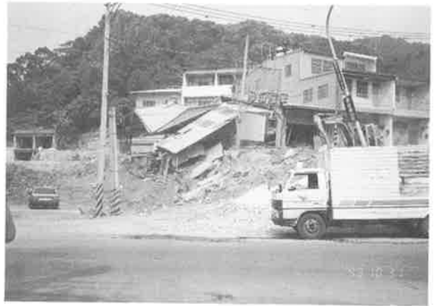
写真一23・24 台中県石岡ダム周辺の町の様子。断層の隆起により、1～6m段差がついている。
