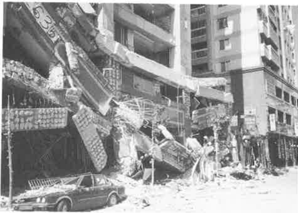
写真—44 Tビル 1階部分の状況
