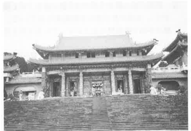
写真一8 南投県日月潭 文武廟 RC造の伽藍配置がシ ンメトリーで大規模な寺院である。中門の柱 頭のせん断破壊と中門左側棟の2階部が崩落 している
