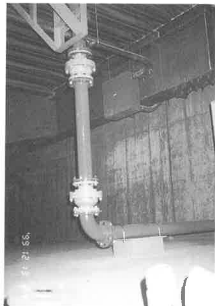
写真-10 免震用配管SHIPシステム
