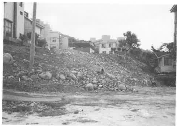
写真一36 台中省轄市大坑周辺 道路に隣接した住宅地の隆起、建物が除去された後
