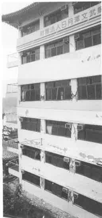
写真一6 南投県日月潭 景聖楼大飯店RC 6階、 全階にわたり柱がせん断破壊している
