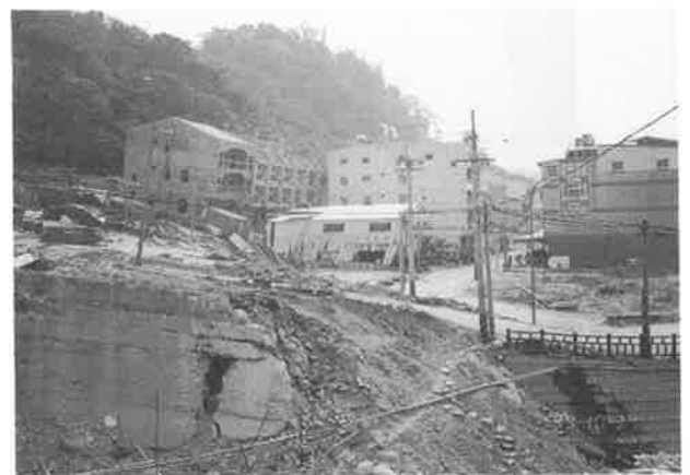
写真一20 石岡ダム周辺の町の様子。手前の川に直角な道路を境に左側が断層の隆起により被害を受けた。
