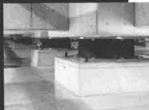
免震装置設置状況 LRB (φ1200)
