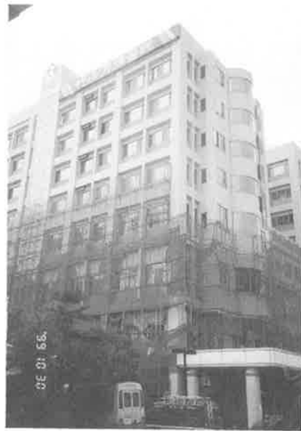
写真一 南投県竹山 T病院RC地下1階、地上8階1997年竣工 外観1~3階に被害が集中している
