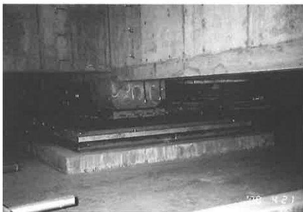
写真-6 施工段階のSBB部の柱脚部全景
