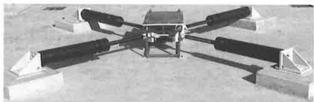
写真四 付加減衰装置RDT設置例
