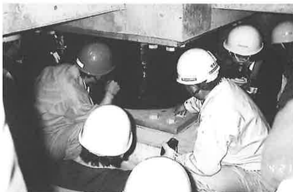
写真-4 現場説明状況 (LLRBを前にして)
