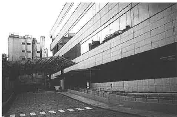
写真-1 建物外観
