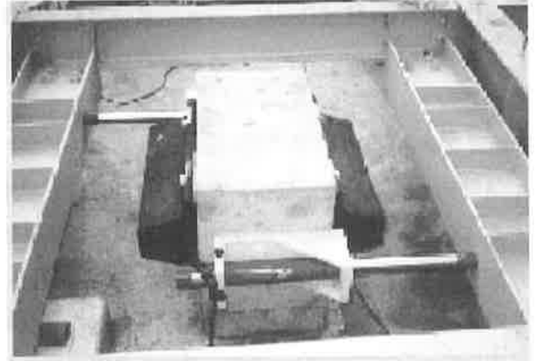
写真-6 耐風ロック装置設置例
