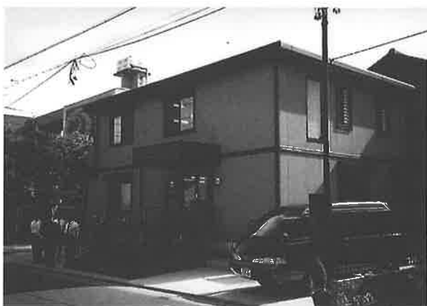
写真-1 建物外観
