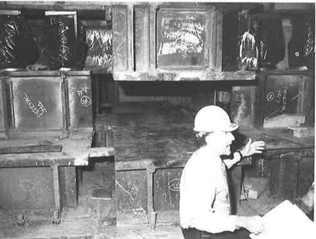
免震装置設置のために設けた柱下空間 (案内の監督ブルース・モーエン氏)
