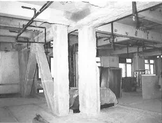
免震装置設置のために設けた柱下空間 (案内の監督ブルース・モーエン氏)
