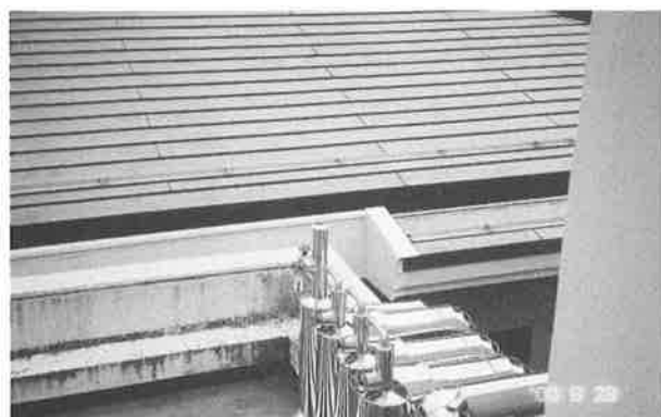
写真8 隣接する分庁舎との境界部分
