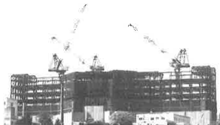
写真-1 工事中の建物風景
