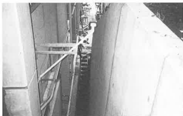
写真7 建物背面の擁壁部
