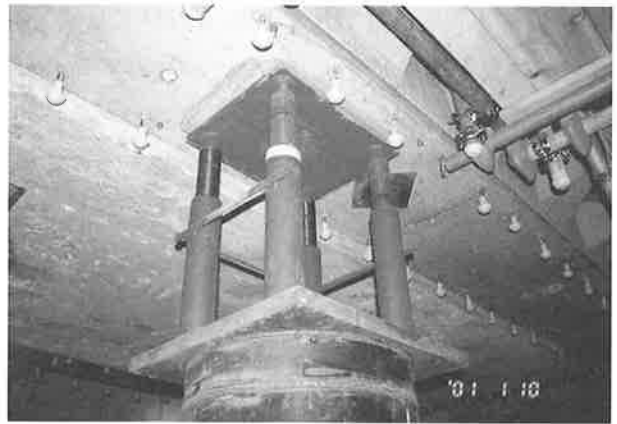
写真6 鋼管杭頭部のサポートジャッキ
