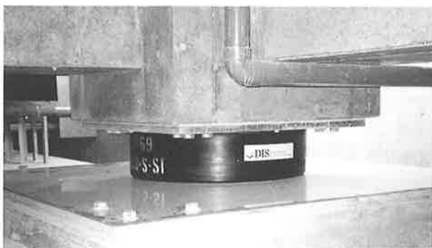
図5 (写真3) 大型鉛プラグ入り積層ゴムLLRBφ1200
