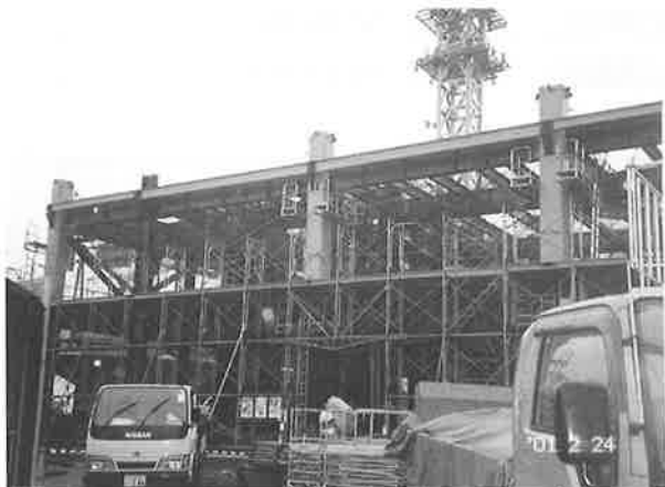
写真2 工事状況外観
