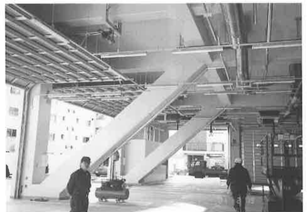
写真2 1階の斜め柱部分
