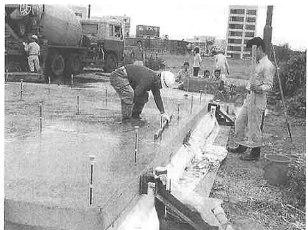
写真4 免震層施工完了状況
