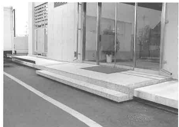
写真-6 エントランスの犬走り
