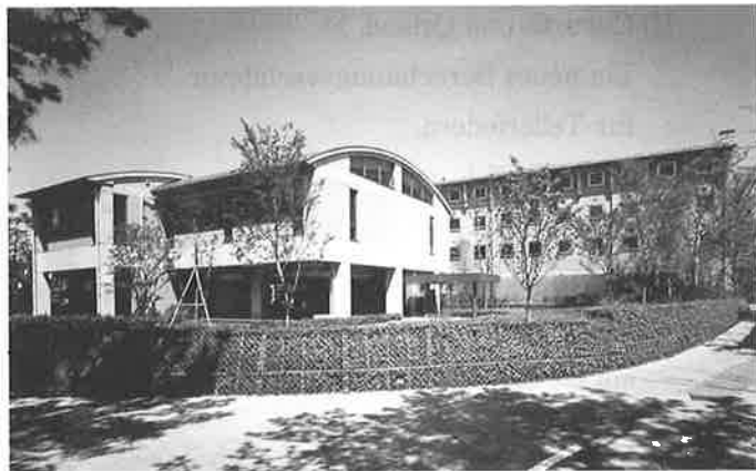
写真-1 建物外観
