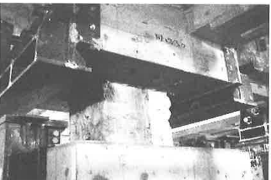
写真-4 柱・梁の補強状況 1
