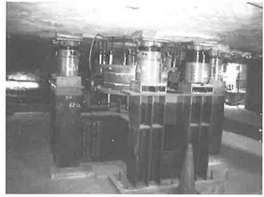
写真-6 仮設ジャッキとアイソレータ設置状況
