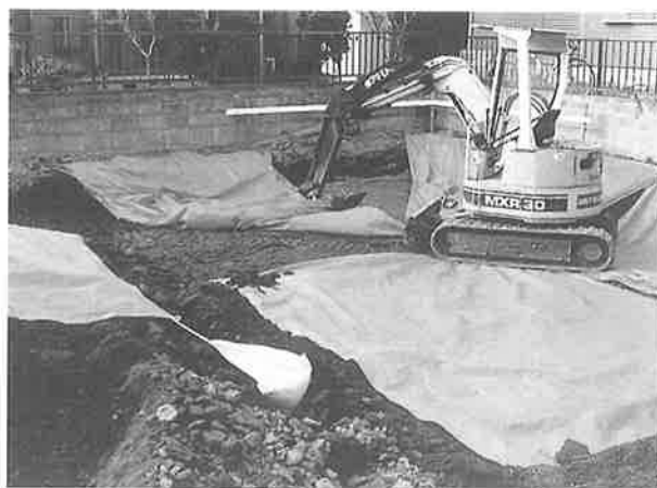
写真-6 根切工事
