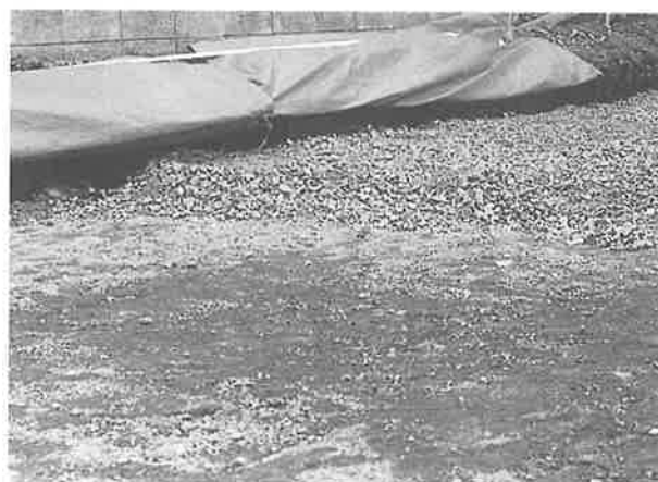
写真-7 GL-0.5mの支持層(ルーム層)及び砂利地業
