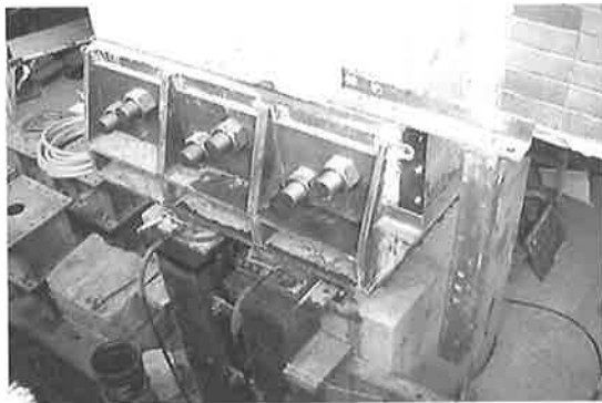
写真-10 免震部材設置状況 4
