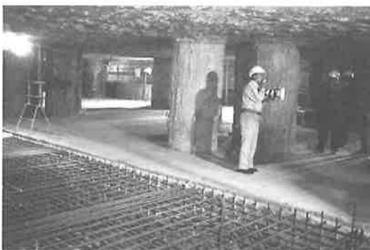
写真-5 マットスラブと既設杭の状況
