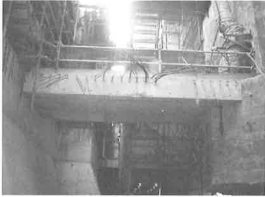
写真-3 仮設スラブの状況
