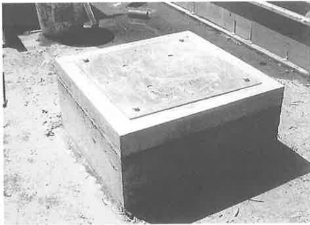
写真-10 免震装置ベースプレート設置状況
