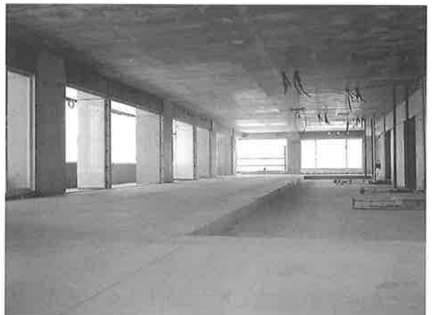
写真-7 基準階躯体出来上がり状況
