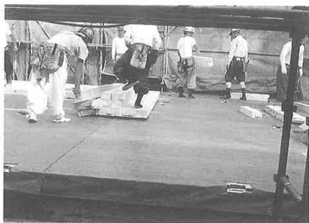
写真-16 木造軸組建て方開始
