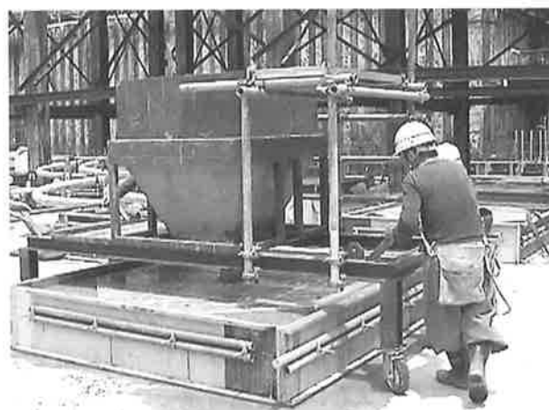
写真-2 免震装置台座コンクリート打設（ホッパー）
