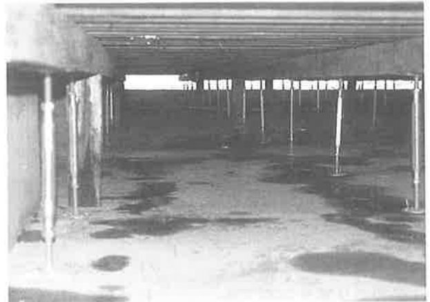
写真-13 免震層内サポート及び 1階スラブ下型枠状況
