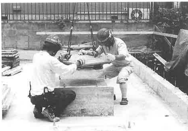
写真-11 免震装置設置状況
