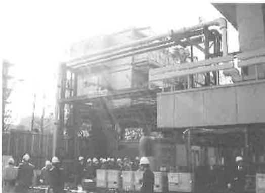
写真-4 ライフラインの仮設状況
