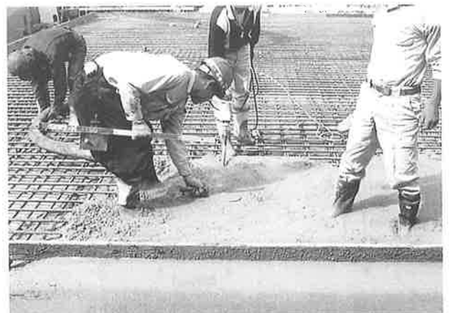
写真-14 1階スラブコンクリート打設状況
