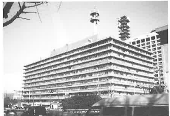
写真-1 建物外観(見学会当日)
