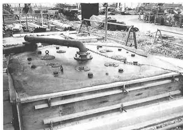
写真-3 免震装置台座コンクリート打設（圧入）
