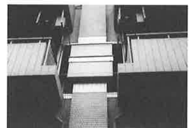
写真-7 外部のALC耐火被覆状態
