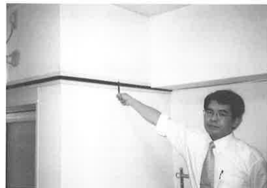
写真-6 居室内の水平スリット
