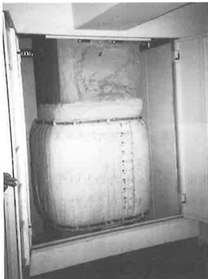
写真-8 室内の耐火状態
