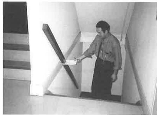
写真-5 階段室の水平スリット
