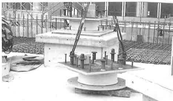
写真1 アイソレーターの取り付け状況
