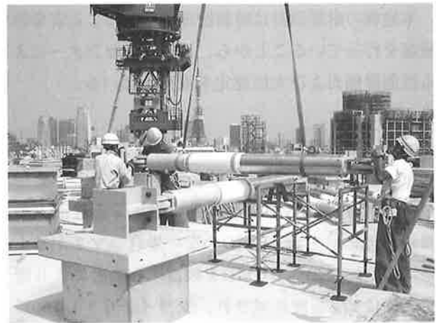
写真2 ダンパーの取り付け状況
