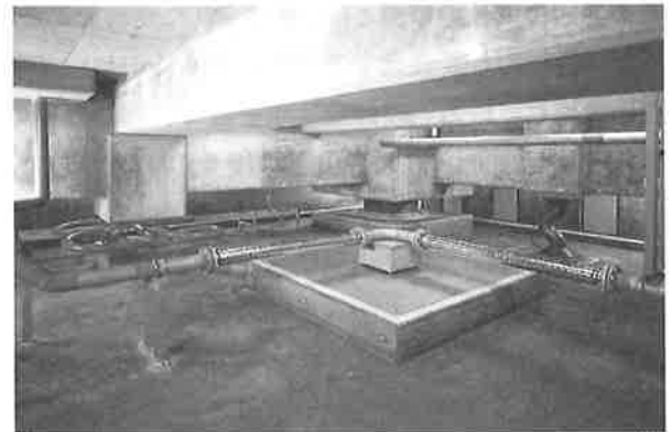
写真-3 免震部材設置状況
