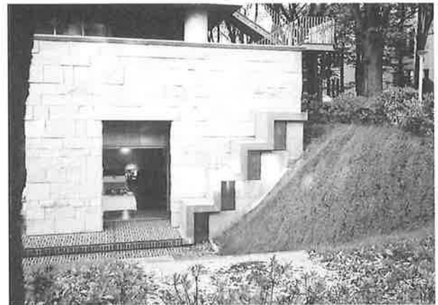
写真一 3 建物東側の可動部外観
