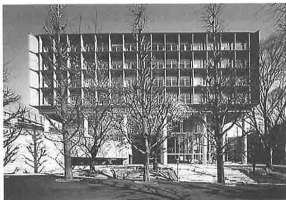
写真-1 建物外観
