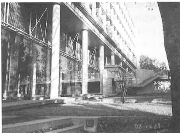
写真一 2 建物南側の外観
