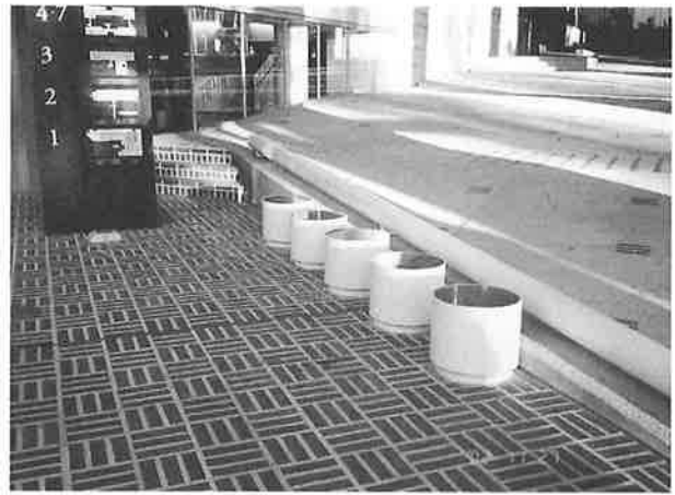
写真-7 通風孔付ベンチ
