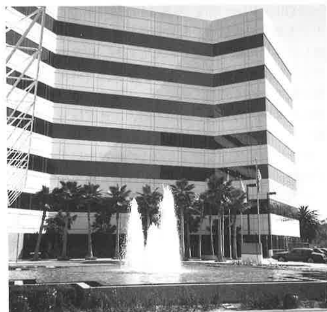
写真4. 免震構造USC病院
