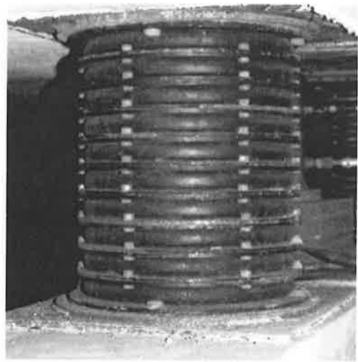
写真-2 加振台浮基礎用積層ゴム
