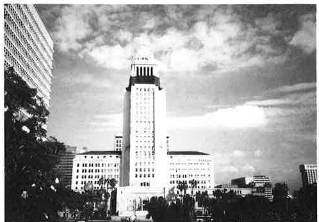
写真7. 免震レトロフィットが決定したロサンゼルス市庁舎
