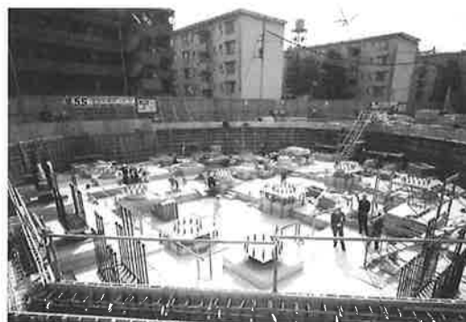
写真-1 建物工事全景
