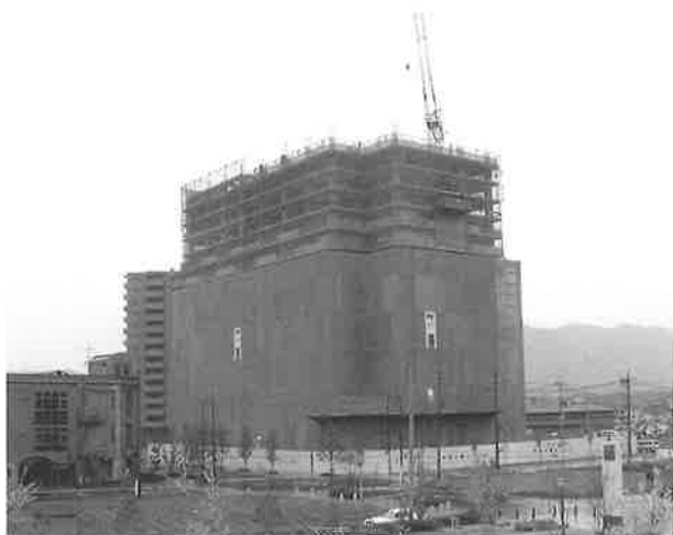
写真一五 建物施工状況
