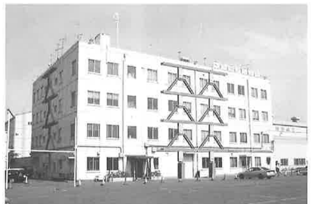
写真-1 適用建物の外観(合成)
