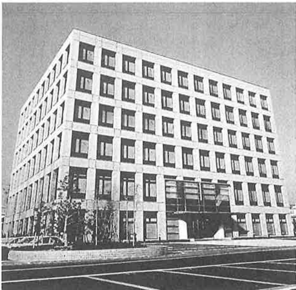
写真-1 建物外観
