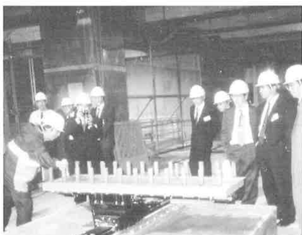
写真一1 直動転がり支承設置風景
