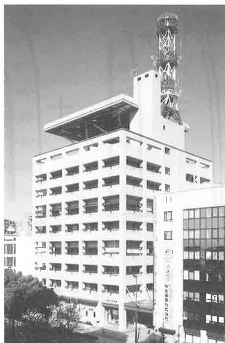
写真-1 建物外観
