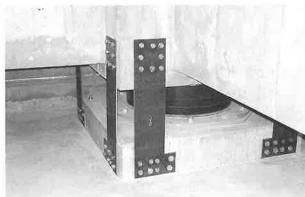
写真一四 固定版取付状況
