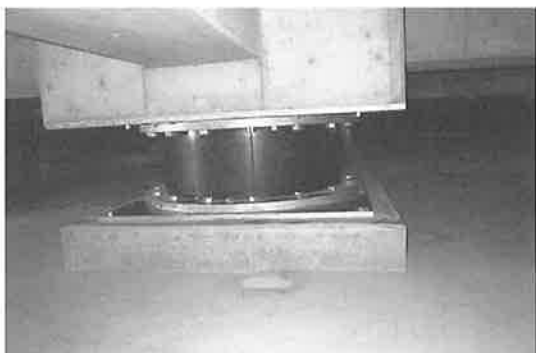
写真一 免震装置設置状況
