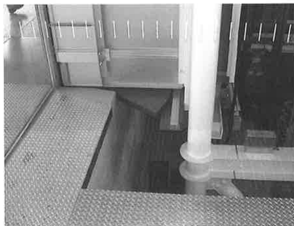
写真-3 エレベータ部クリアランス
