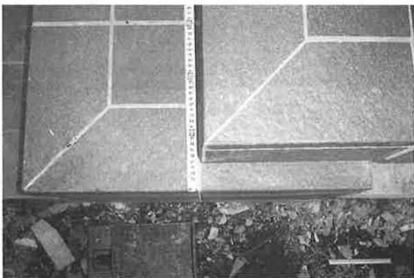
写真7 加力時の建物移動状況
