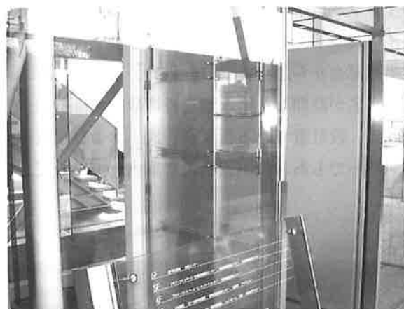
写真-2 エレベータ部
