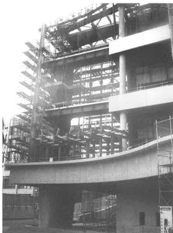
図11 アトリウム建て方風景
