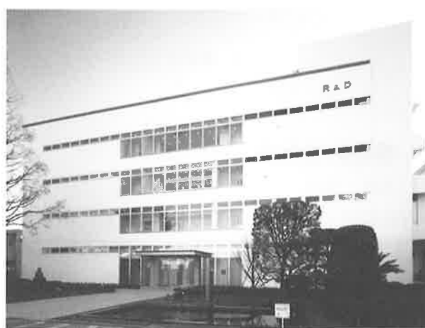
写真-1. 建物外観
