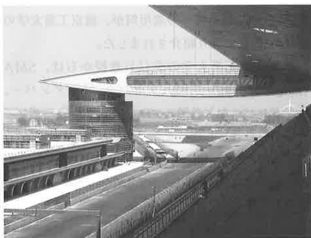
写真2 建設中の上海サーキット
