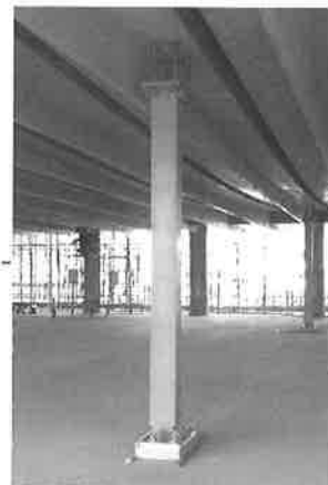
図3 床制振用粘弾性ダンパー
