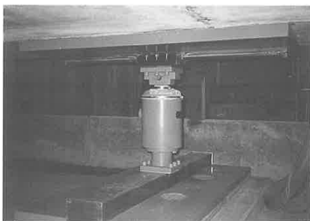
写真-9 上下制震用粘性ダンパー
