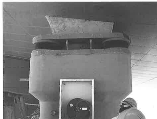
写真3 大スパン構造の免震支承
