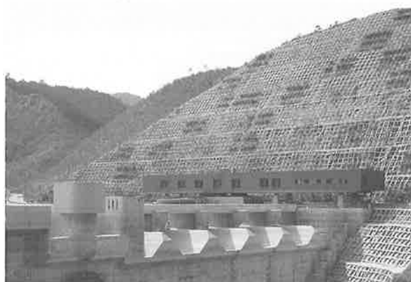
写真1 苫田ダムと管理所
