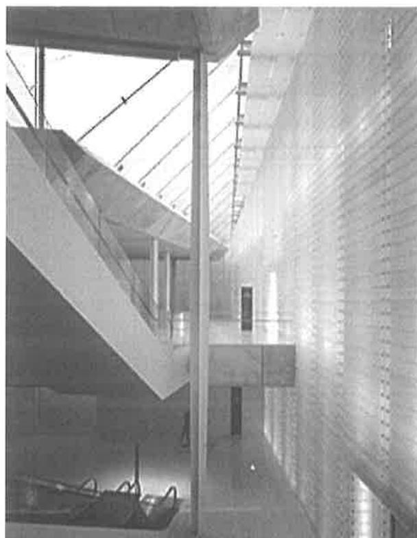
写真-6 ロビーの十字柱 (撮影：石黒 守)
