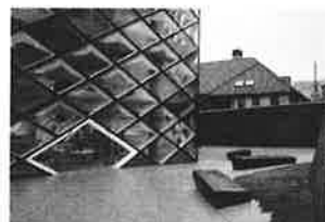
1階エントランス外観
