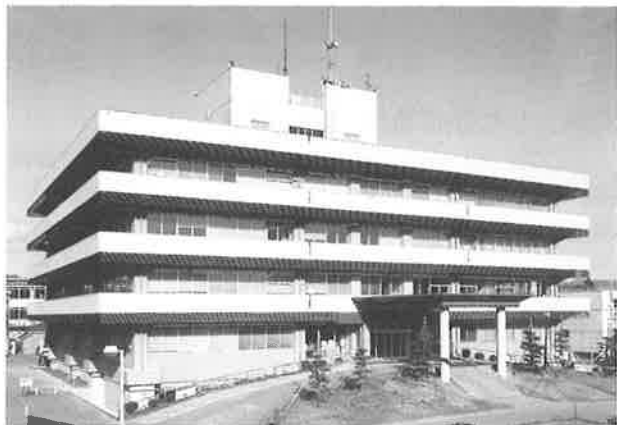
改修後建物外観 (撮影：上山益男)
