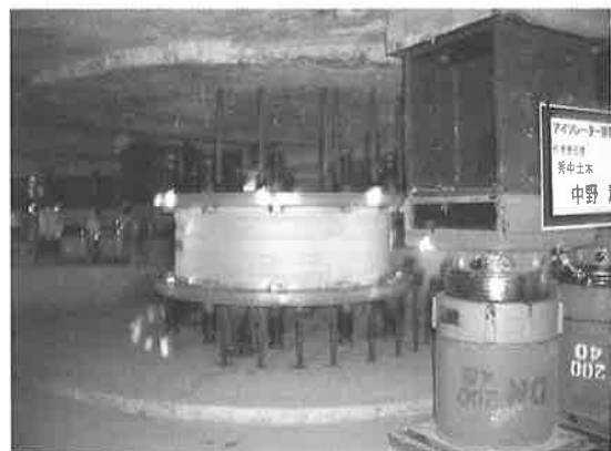
写真-3 免震装置の設置状況
