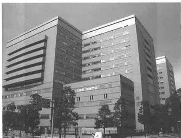
写真6 F建物の外観
