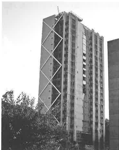
写真-1 東京工業大学高層免震棟
