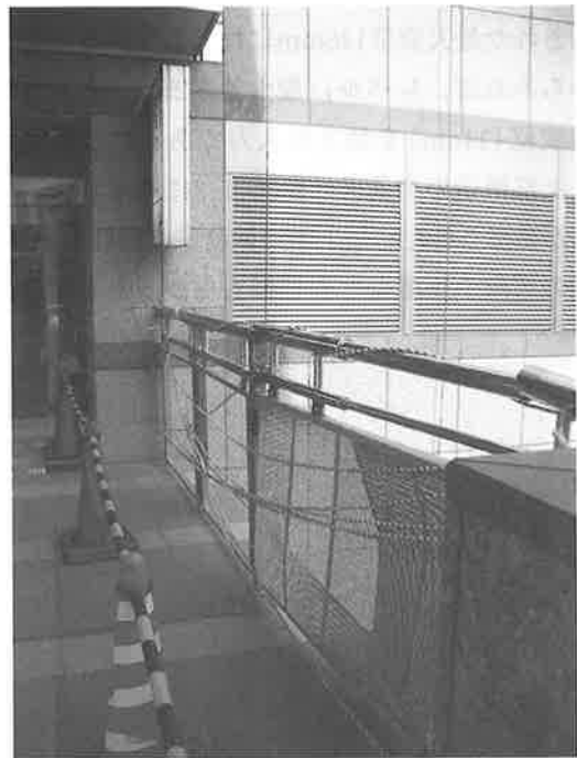
写真7 F建物のエキスパンションブリッジ
