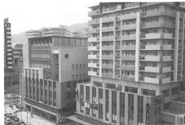
写真-6 見学建物の現在外観 (平成17年3月撮影)
