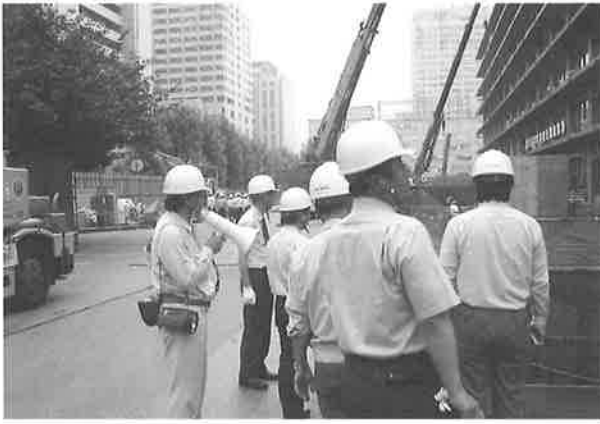
「外務本庁舎耐震改修工事」現場見学状況
