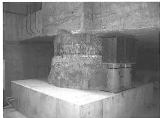
写真-2 既存杭の状況
