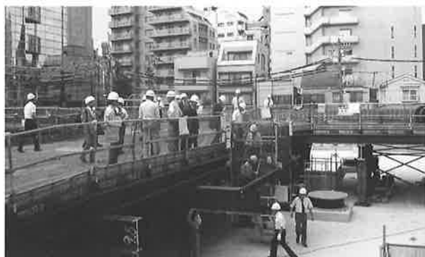
恵比寿一丁目共同ビル現場見学状況
