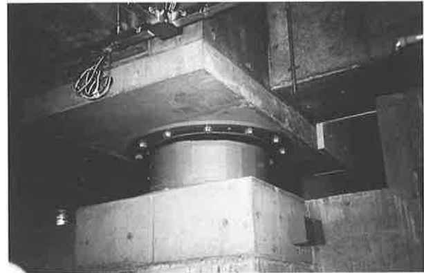
写真-5 免震部材設置状況
