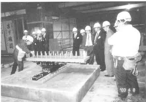
写真-1 直動転がり支承設置風景
