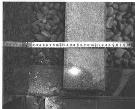
建物が南北に11cm~15cm程度動き、縁石が移動している。
