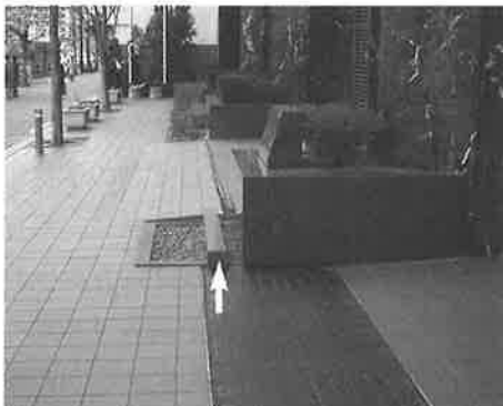
建物が南北に11cm~15cm程度動き、縁石が移動している。
