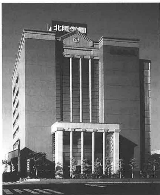
写真1 北陸学園総合本館
