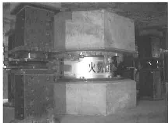
写真-4 免震装置の設置状況
