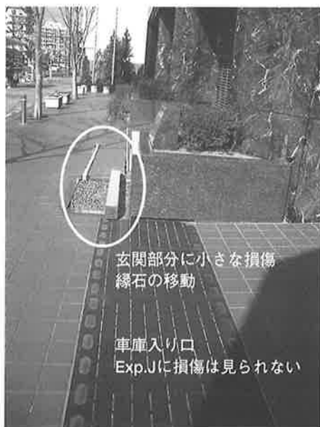
写真2 D建物の玄関アプローチと車庫入り口
