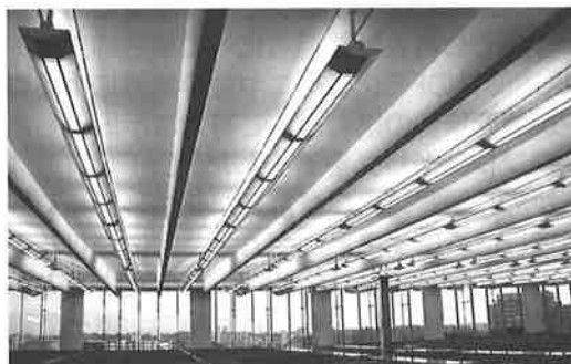
執務室内観（PC構造の天井と間接照明）
