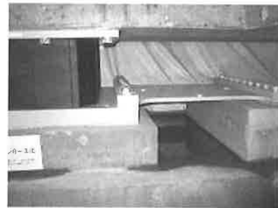
写真-2 ウインカー工法
