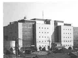
静岡銀行草薙ビル (撮影：エスエス名古屋)
