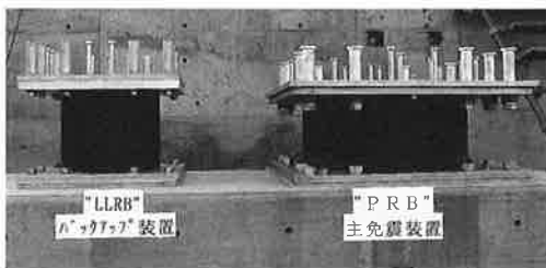
写真4 免震装置取付状況
