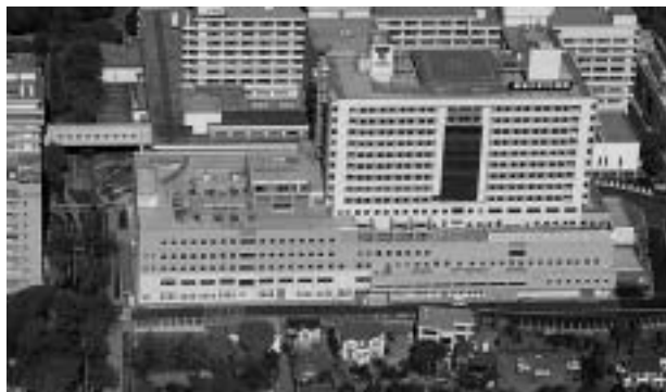
■図1 建物外観写真
