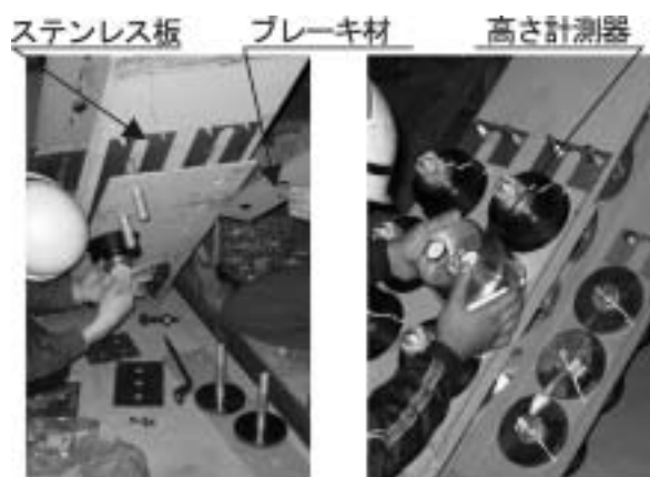
■写真3 組み立て状況
