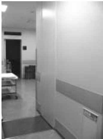
■写真4 建物内のエキスパンション
