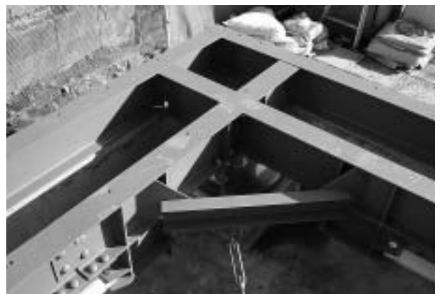
■写真6 建物隅部納まり
