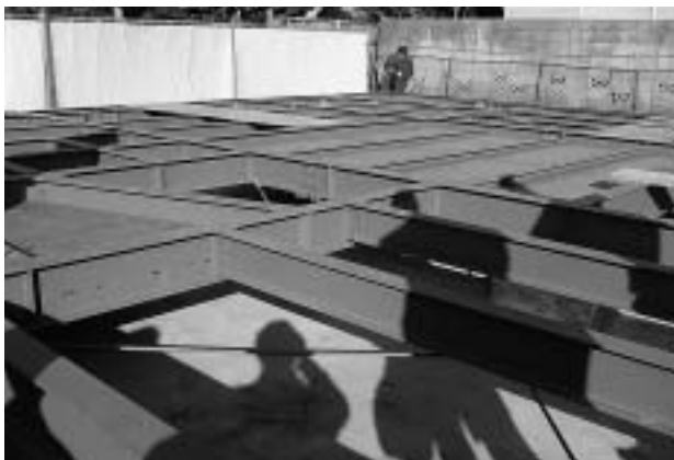
■写真1 建物全体
