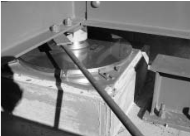
■写真2 転がり支承 (ボールベアリング支承)
