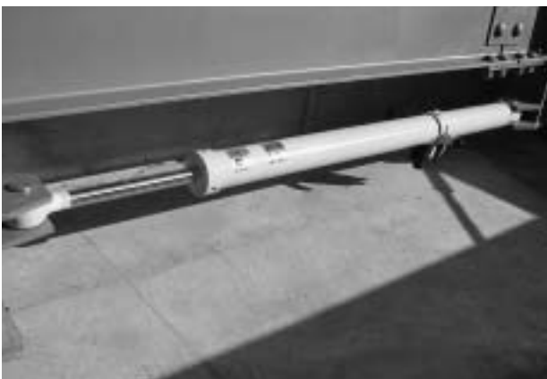
■写真3 流体系支承 (オイルダンパー)
