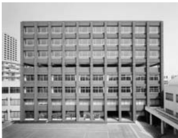
写真4 建物竣工時外観
