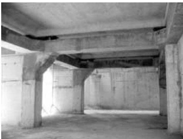
写真6 建物“Cascade”の免震装置
