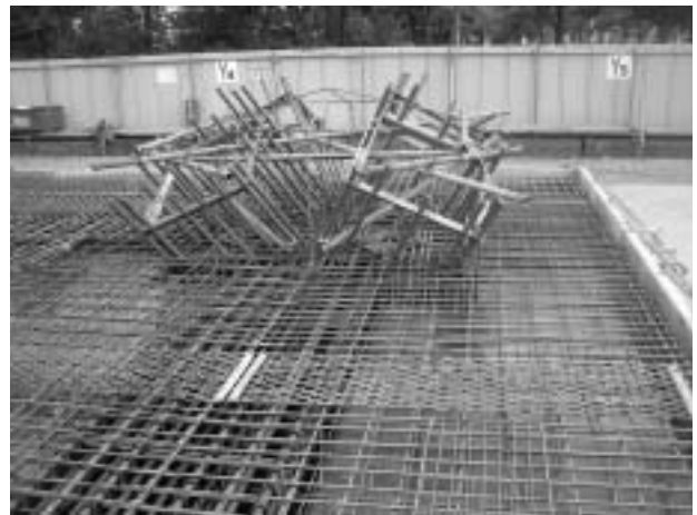
写真1 斜め柱柱脚配筋施工中写真
