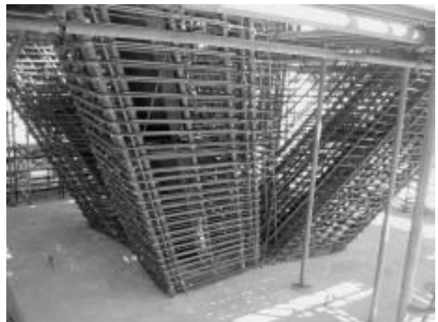
写真2 斜め柱配筋施工中写真
