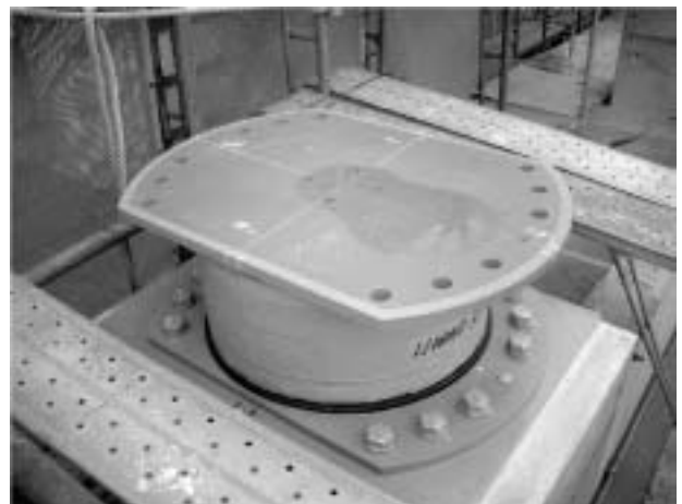
写真2 免震装置設置状況
