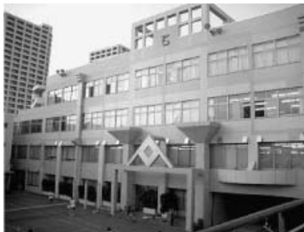
写真1 既存建物全景
