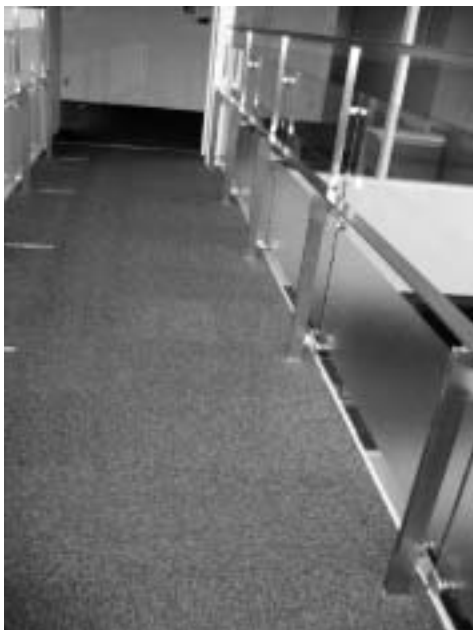
写真10 ダクトブリッジ
