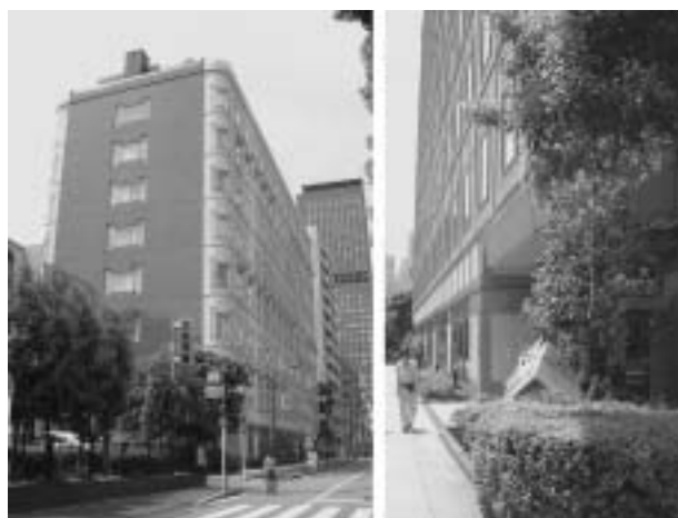
写真1 建物外観(竣工時)
