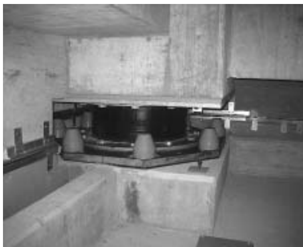
写真7 引き抜き対応治具
