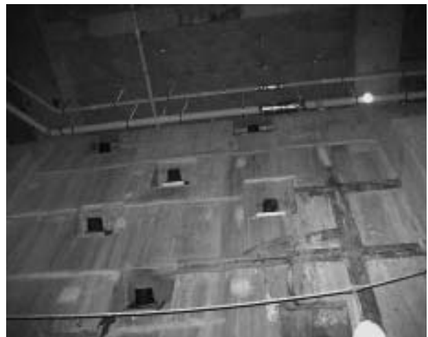
写真2 擁壁と永久アンカー定着部
