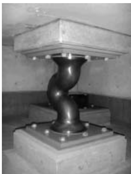
写真2.3 U型鉛ダンパー
