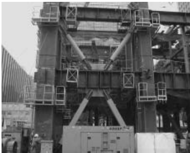
写真2 アンボンドプレート設置状況
