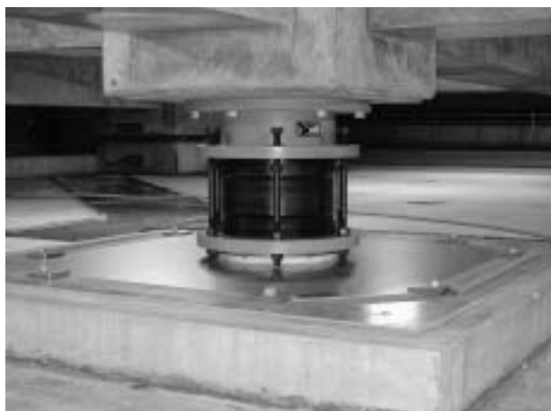
写真2.4 摩擦皿ばね支承
