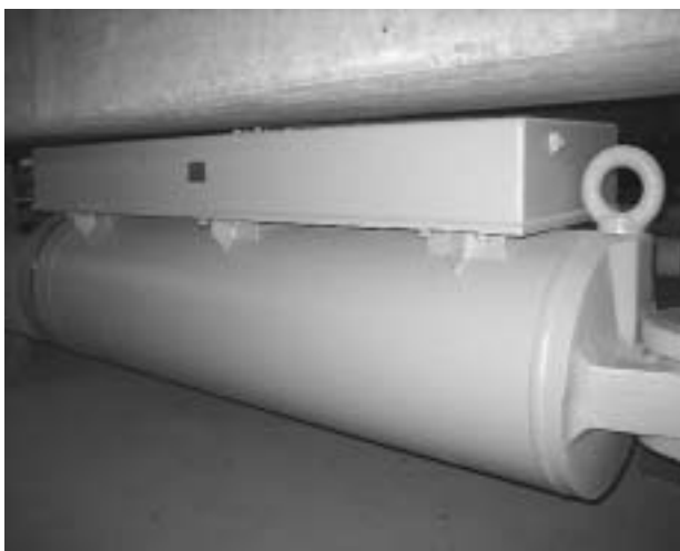
写真3 オイルダンパー
