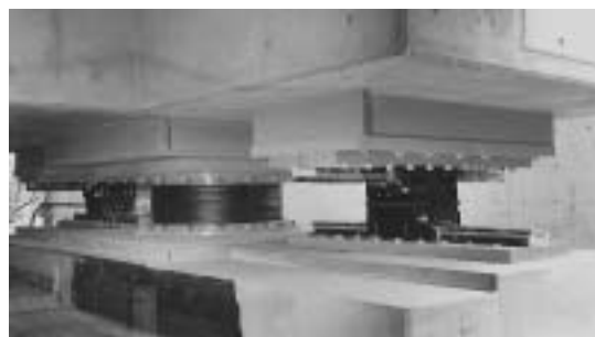
柱直下に設けた積層ゴムと補強梁先端に設けた転がり支承（撮影：三島 勲）
