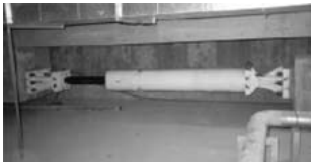
写真2.10 筒型粘性ダンパー
