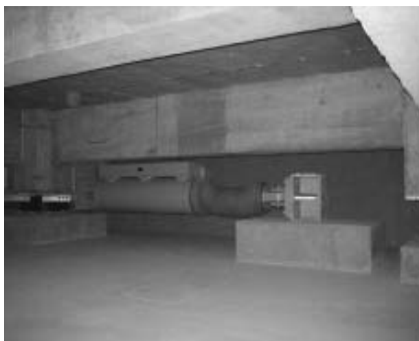
写真6 ダンパー取付部
