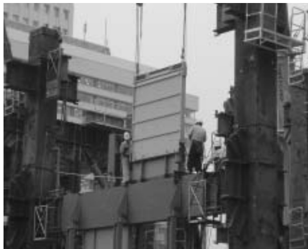
写真3 制震壁設置状況
