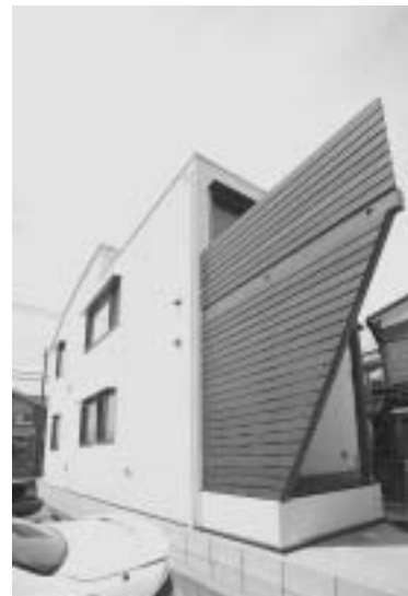
本免震装置を適用した実施物件の概観（撮影：岡部株式会社）
