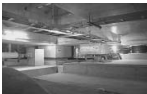
写真4 免震部材設置状況
