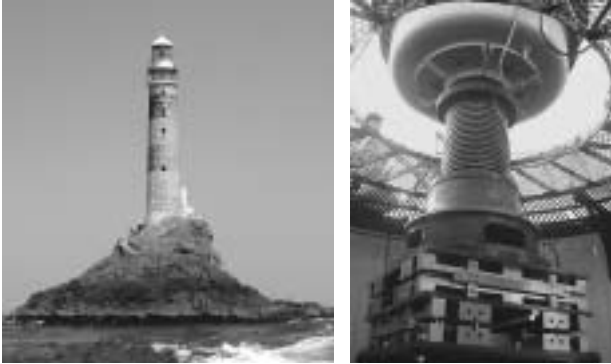
水の子島灯台(大分県)と3等レンズ用免震装置(撮影:川井伸泰)
