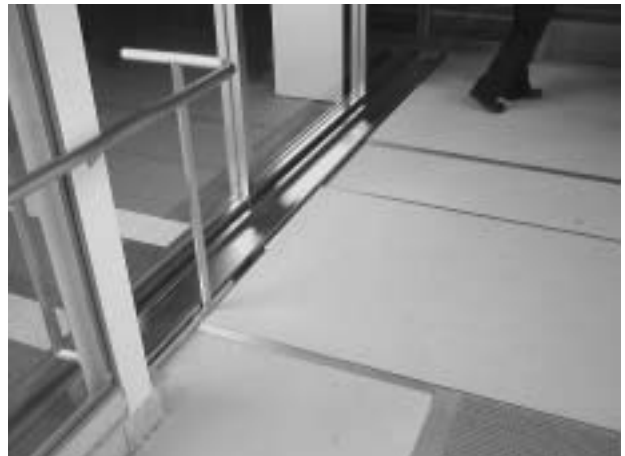
写真11 ローラー側の床のおさまり
