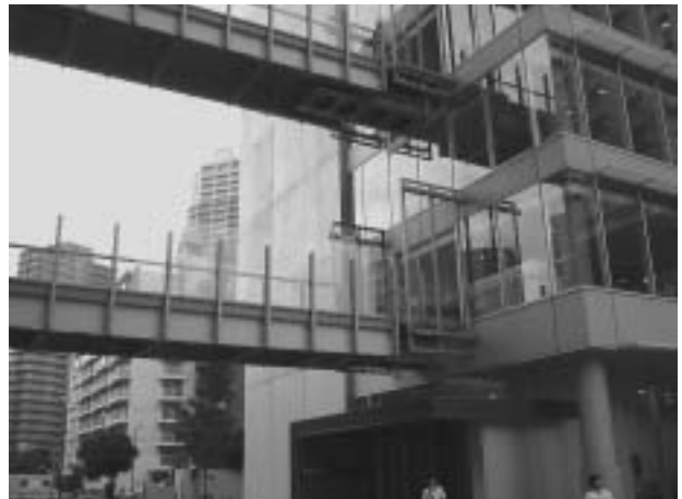
写真10 交流棟と教室棟を接続する棟間ブリッジ
