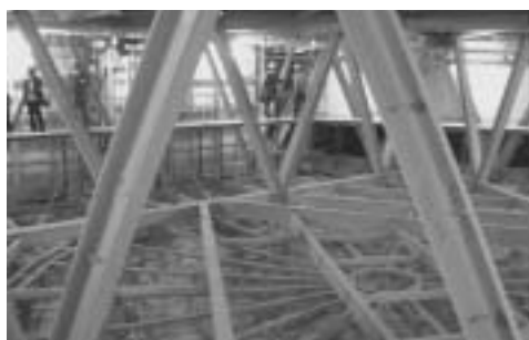
写真3 スカイガーデントラス内部見学風景
