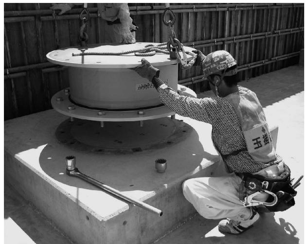
写真2 免震材料の設置
