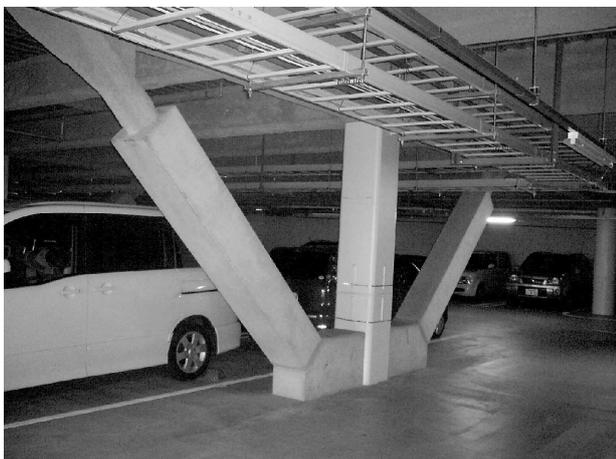
写真5 駐車場のRC被覆アンボンドブレース
