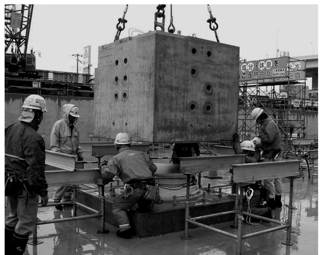
写真3 免震材料とPCaフーチング
