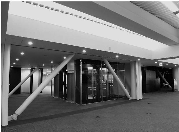
写真12 二重鋼管座屈補剛ブレース
