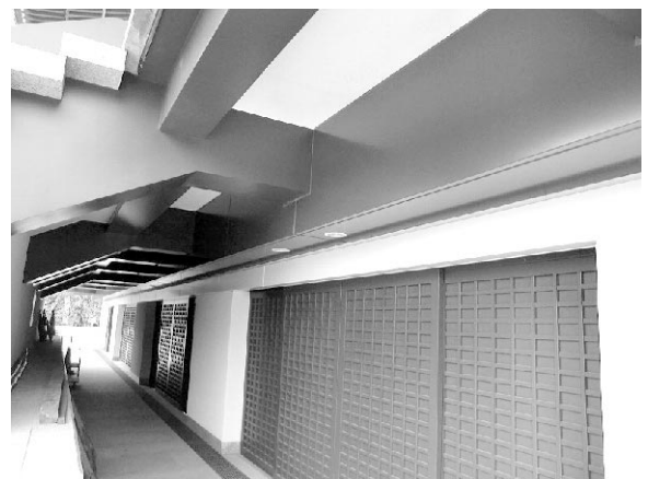
写真7 1階外壁の状況
