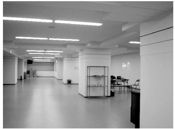
写真6 免震層の状況
