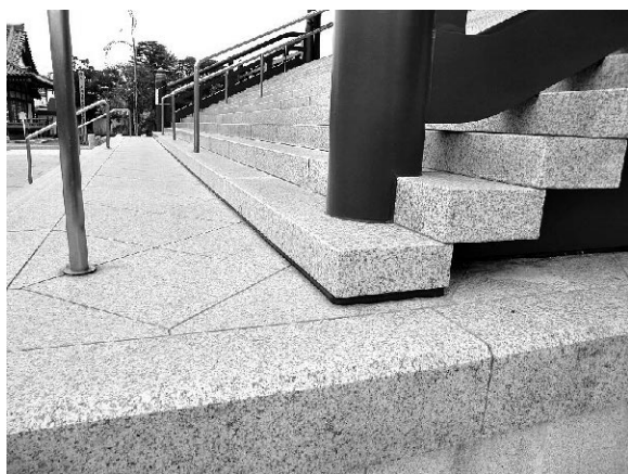
写真9 正面階段エキスパンション部
