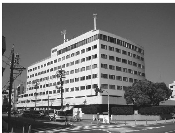
写真1 改修前の建物全景
