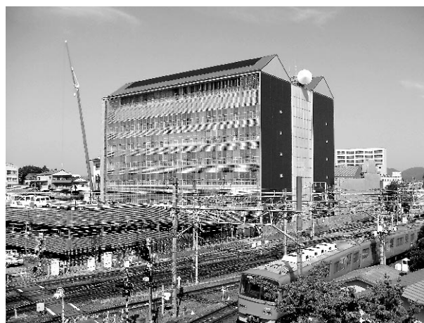
写真3 竣工間近の南東側外観
