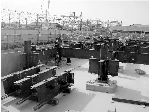
写真1 鉄骨0節建方状況
