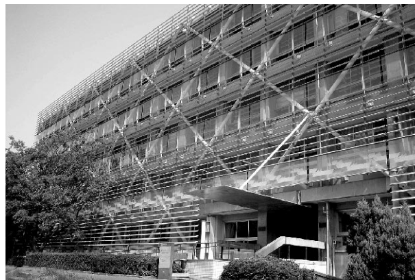
写真2 緑が丘1号館(改修後)
