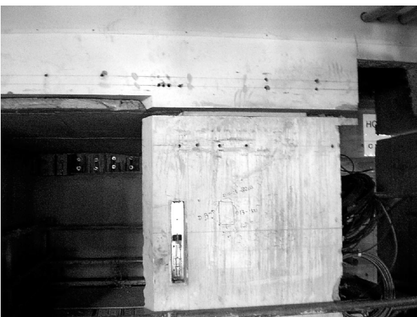
写真10 階段室RC壁の施工状況
