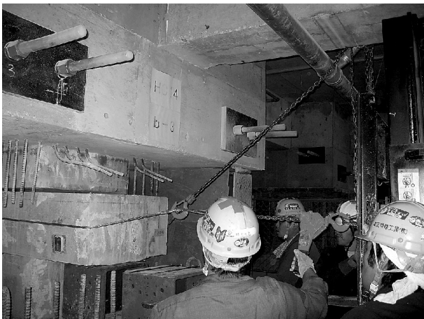
写真3 柱切断部取り除き
