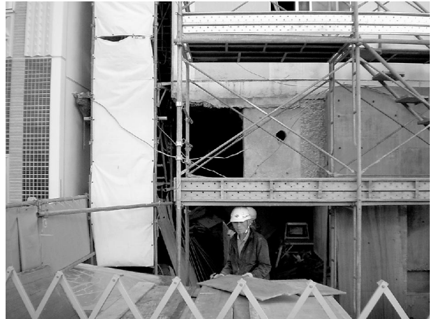
写真11 棟間部分施工状況
