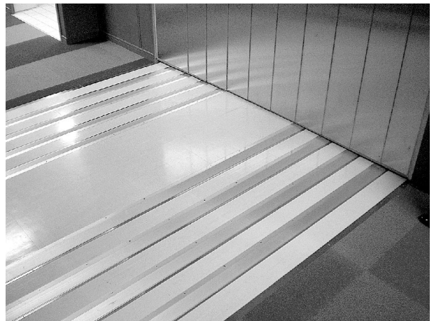
写真12 エクスパンション・ジョイント(床、壁)
