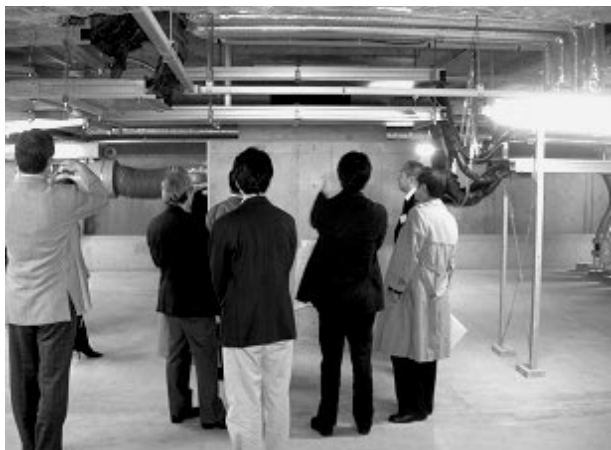
写真6 免震層の見学の様子(2)
