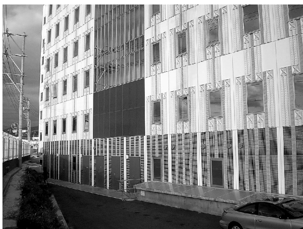
写真14 Pca版を用いた新新館の外観
