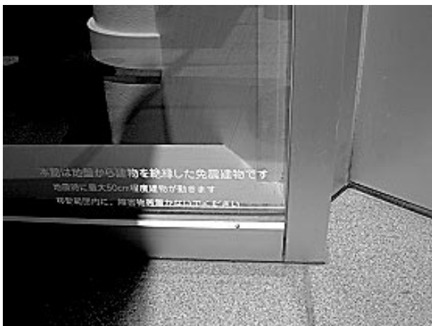
写真3 免震建物の表示
