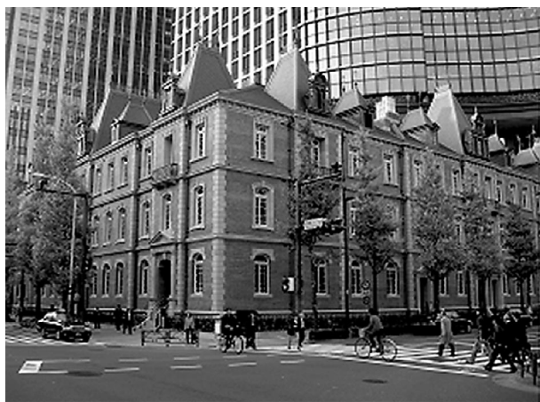
写真1 復元された建物全景
