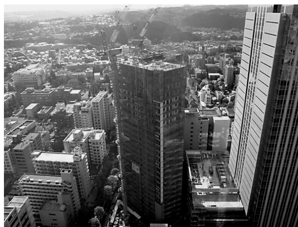
写真1 作業所全景 (H21.11)
