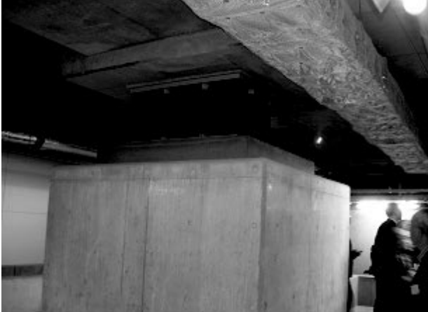
写真5 免震層の見学の様子(1)
