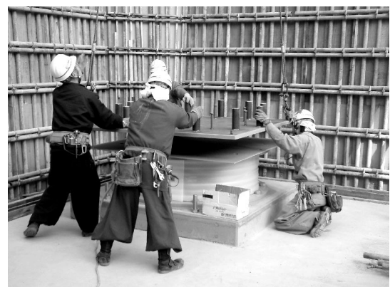
写真3 天然ゴム系積層ゴム設置状況
