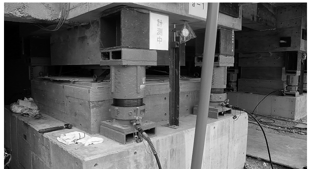
写真6 弾性滑り支承部分ジャッキダウン完了後状況
