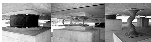
積層ゴム 鋼棒ダンパー 鉛ダンパー 図2 免震装置の写真
