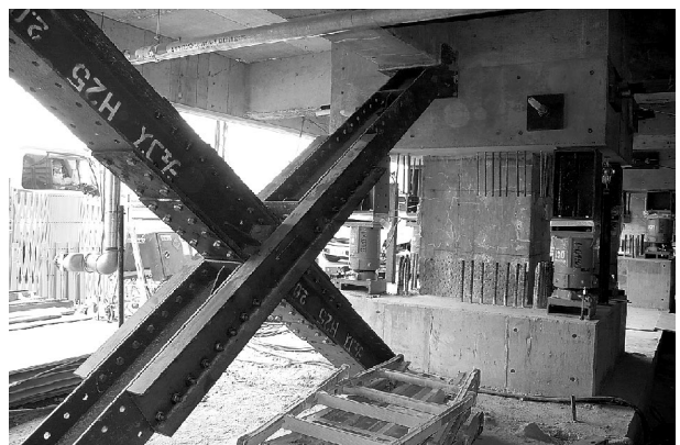
写真7 仮設耐震ブレース
