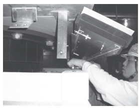
手前のパネルを外しています
