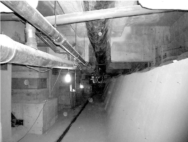
写真8 耐震構造部分との境界部分
