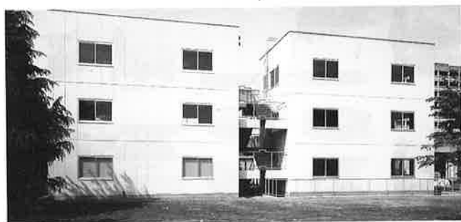
写真-1 東北大学免震実証試験建屋の全景 (左：在来構法、右：免震構法)
