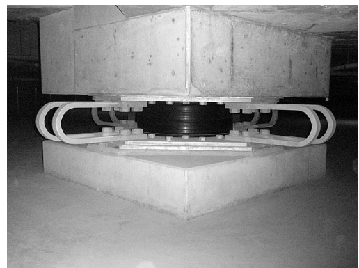
写真3 鋼製U型ダンパー一体型積層ゴム
