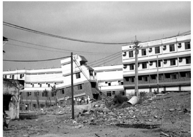
写真 1999年台湾・集集地震の断層直上における建物被害
