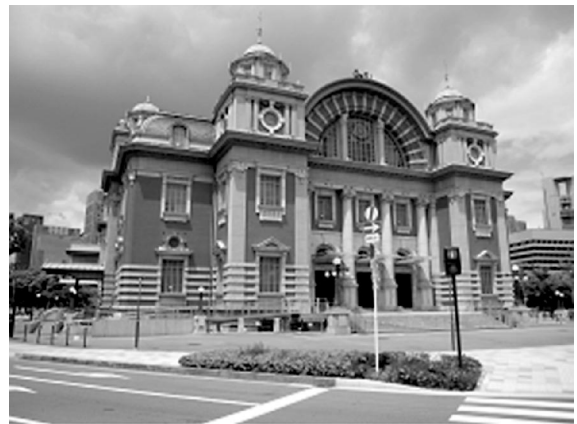
写真4 中央公会堂外観(2010年5月)
