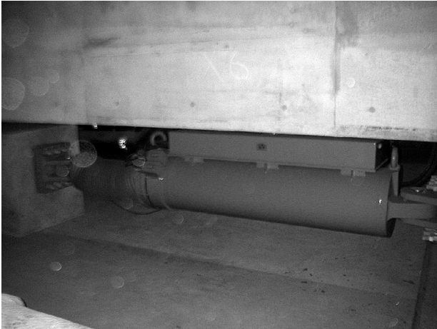
写真8 可変減衰ダンパー
