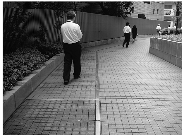
写真11 建物外周クリアランス部
