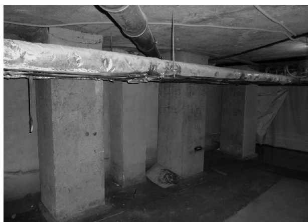
写真6 地下階のロッキング柱
