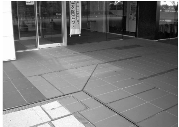
写真5 1階外部エキスパンションジョイント
