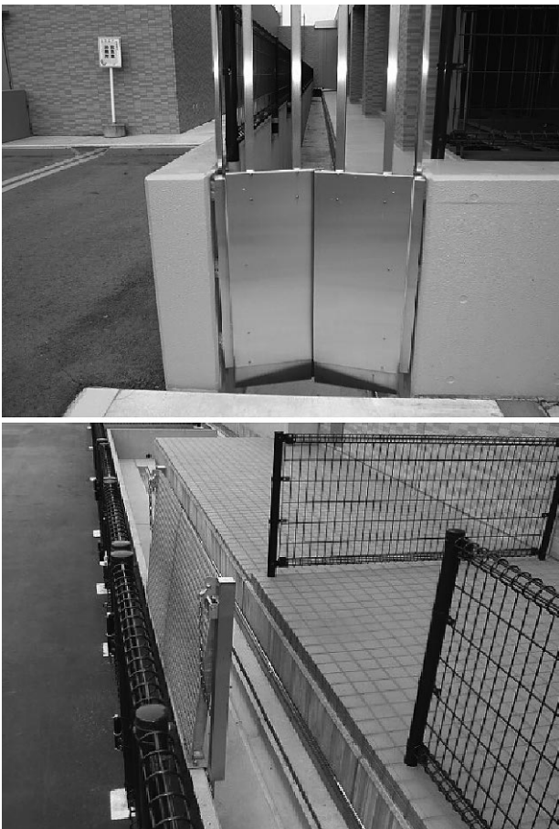
図11 外部跳ね出しEXP.Jの状況
