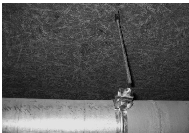
図8 免震層配管吊材の切断
