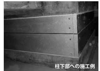
柱下部への施工例
