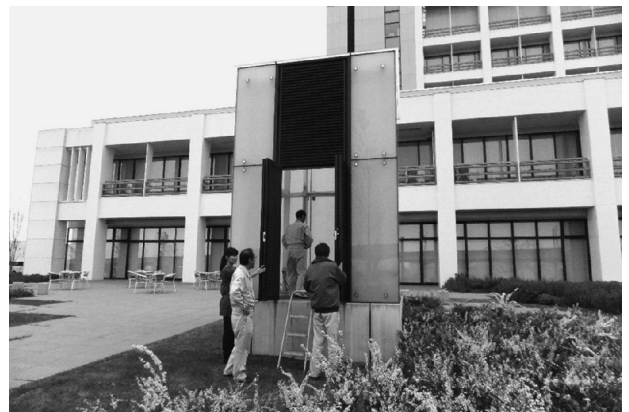
写真3 空気取り入れ用タワー
