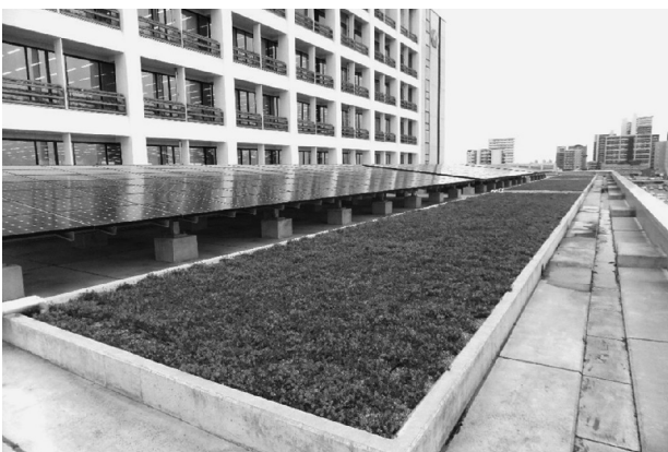
写真5 屋上緑化、太陽光発電施設
