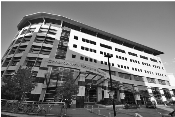
図9 地震後の病院外観
