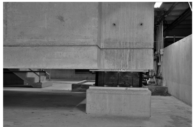
図10 地震後の免震装置 (LRB)
