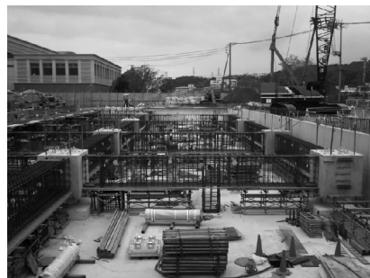
工程2 1階RC梁の配筋
