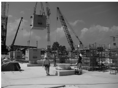
工程1 免震ブロック架設
