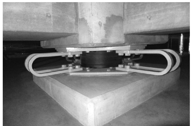
写真2 免震層の状況
