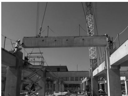
工程4 PCa梁の架設
