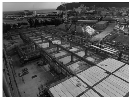
工程5 PCa床版の架設
