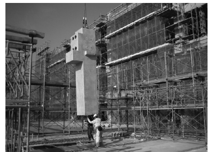
工程3 PCa柱の架設
