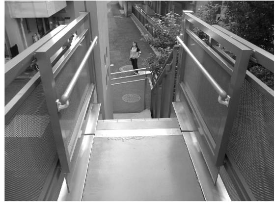
写真9 外部階段 Exp.J(2階床面)
