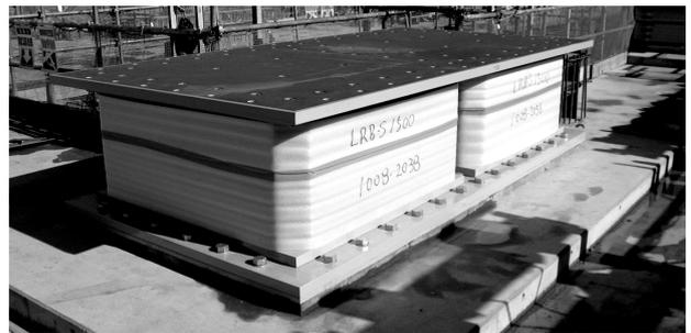
図8 免震装置設置状況
