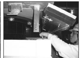
固定式耐火パネル仕様 / 柱・天然ゴム系積層ゴム免震装置耐火被覆システム
