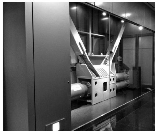
図12 制振ユニット取付状況
