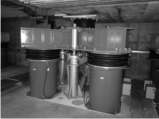
写真6 3次元免震装置設置状況
