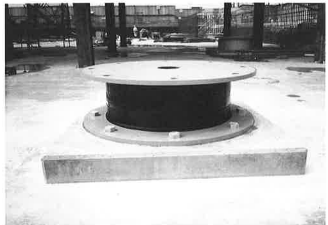
写真一5 免震装置設置状況 (H7. 4月中)
