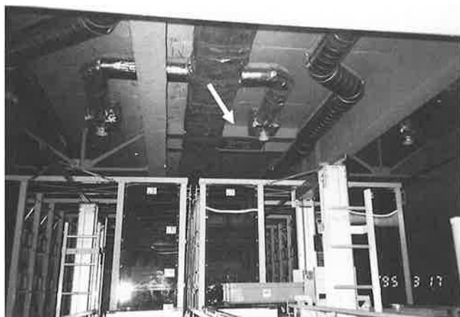
写真—2 TMD設置状況
