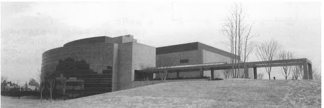
写真一1 建物全景
