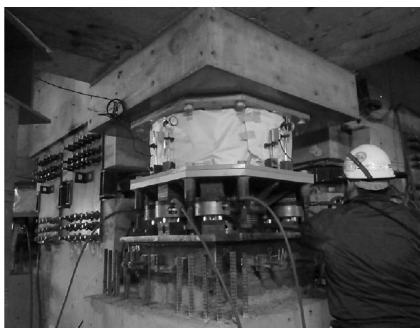
写真5 プレロード導入状況
