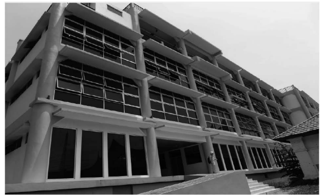
設計協力したインドネシア・スマトラ島・パダンの基礎免震建物 (手前のスロープは建物に接しているため、切り離しを要請してきた。)
