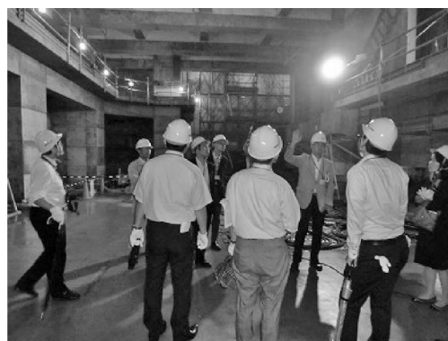
写真5 工事中の免震層での説明状況
