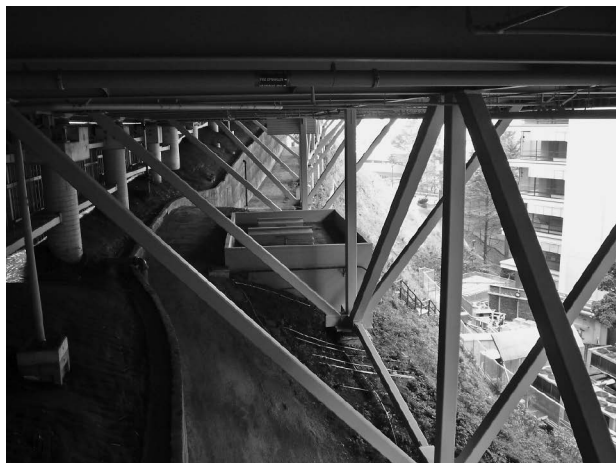
写真3 床下の立体トラス
