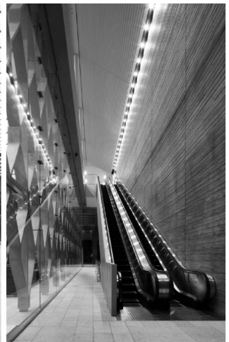
コアウォール本実打放し (撮影：すべて㈱PD システム)
