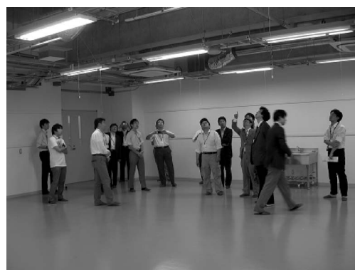
写真7 天井の空調室内機の説明状況
