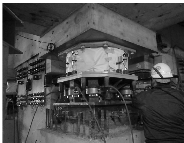
写真5 プレロード導入状況
