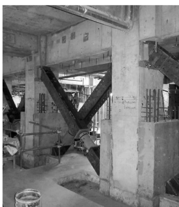
写真2 仮設ブレース
