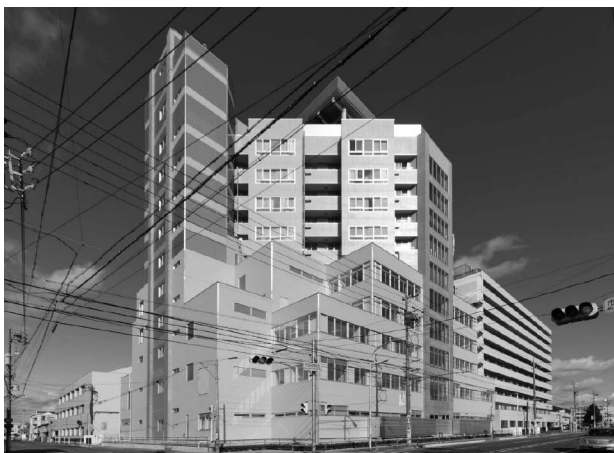
建物外観（撮影：SS名古屋）
