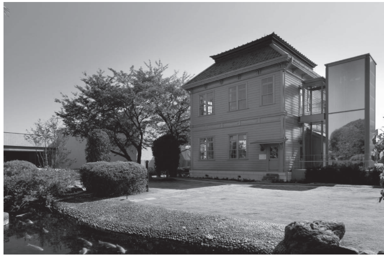
製粉ミュージアム館全景
