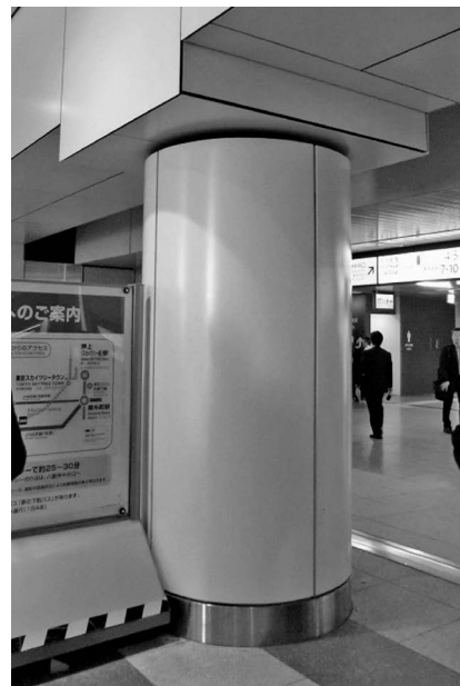
写真6 柱頭免震部分（総武階段部）
