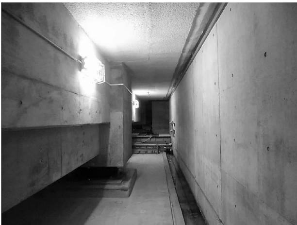
写真5 免震層外周部
