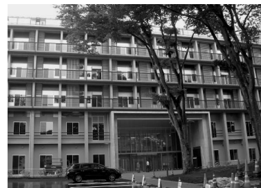
写真4 マテリアル・開発系実験研究棟（免震）外観
