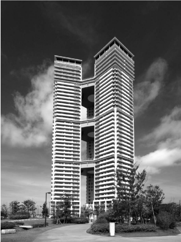
写真1 アイランドタワースカイクラブ外観
