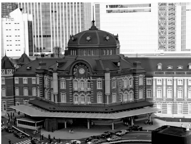
写真4 復原された北側ドーム外観
