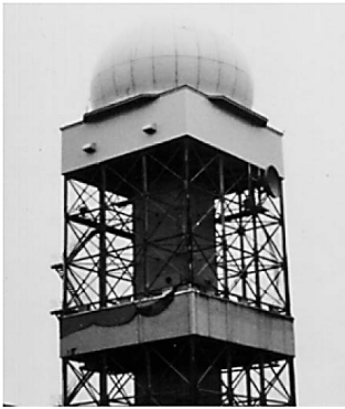
免震レーダーサイト
