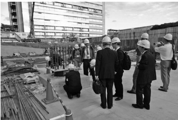
写真12 人間環境系実験研究棟の現場見学
