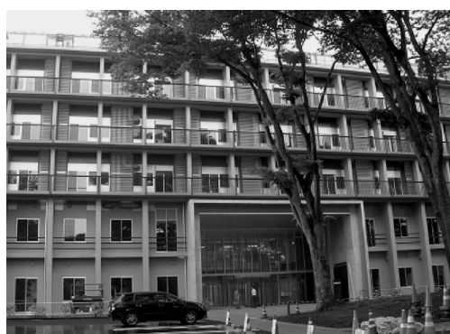
写真6 見学時の建物外観
