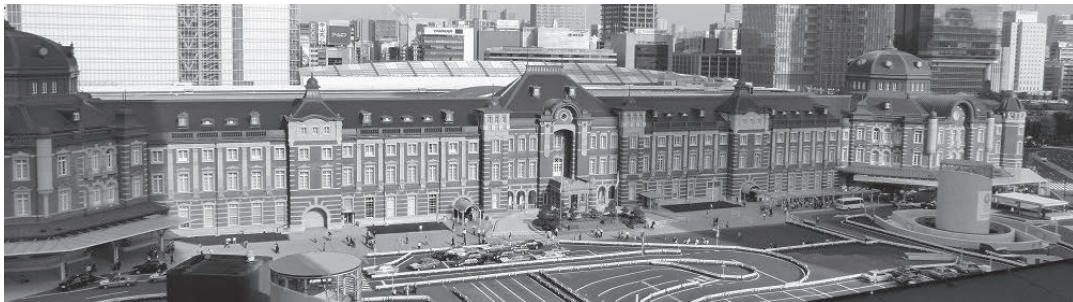
写真1 東京駅丸の内駅舎（免震レトロフィット）全景
