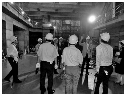
写真5 工事中の免震層での説明状況
