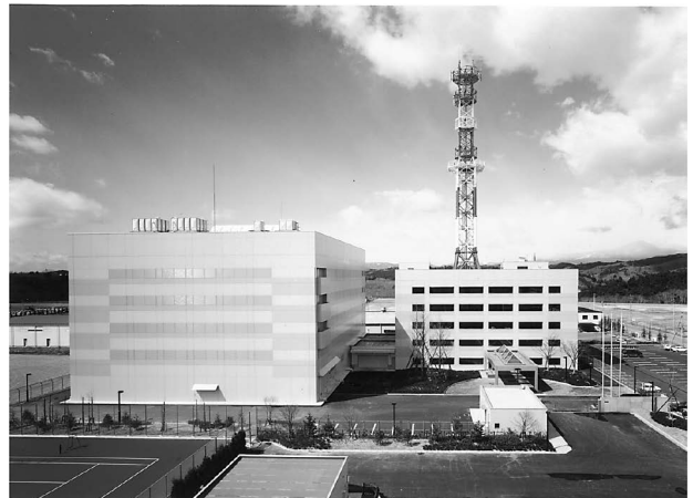
写真1 建物外観（左側が電算センター）
