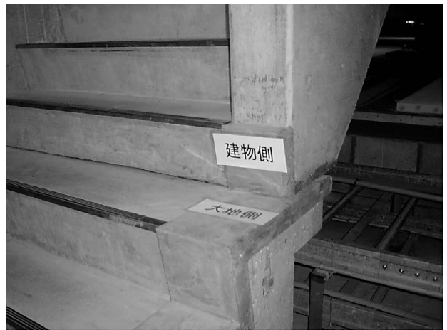
写真7 免震層のEXP階段
