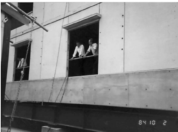
RC造2階建て免震建物実物載荷試験
