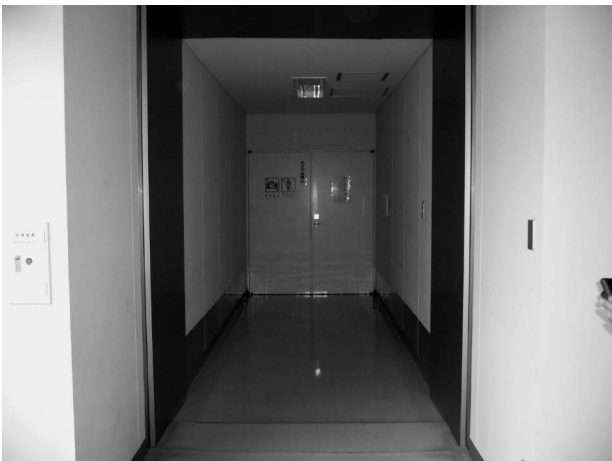
写真11 免震棟と非免震棟の連結部
