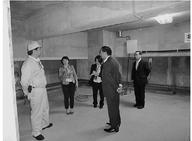
写真6 免震層見学状況
