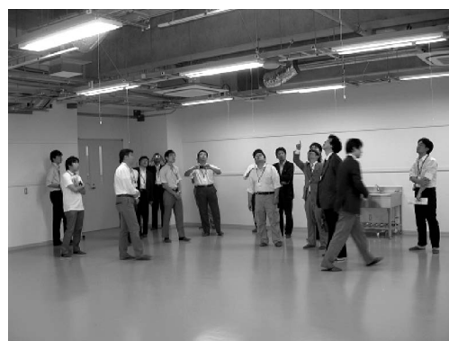
写真7 天井の空調室内機の説明状況
