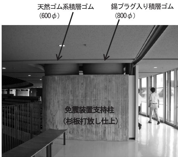
写真5 免震装置設置状況
