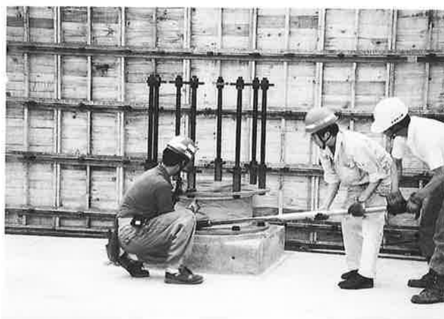
写真-3 免震装置の設置状況
