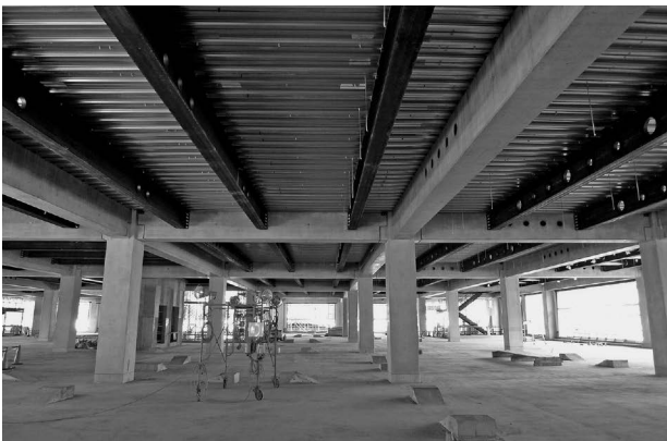
写真3.2 PCaPCラーメン架構と鉄骨小梁
