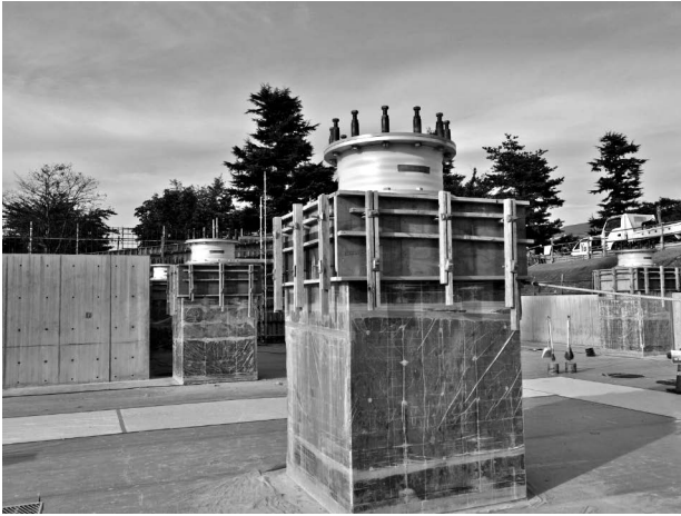
写真3.1 免震装置の設置状況
