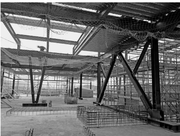
写真3.3 4階鉄骨ブレース
