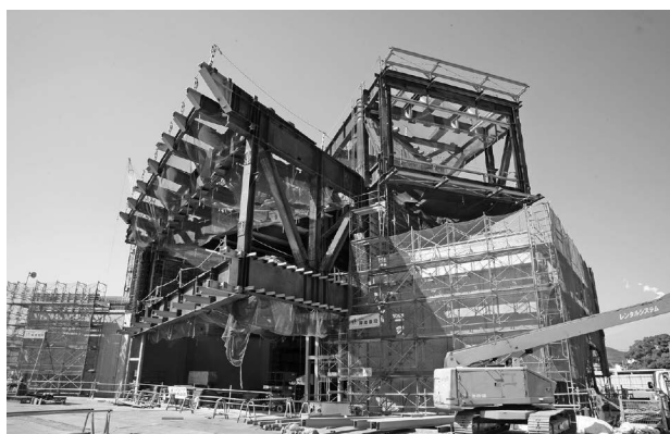
写真2 鉄骨建て方時写真
