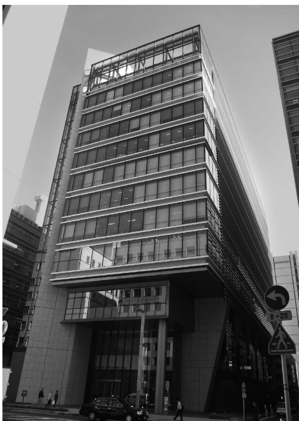
写真1 建物全景写真
