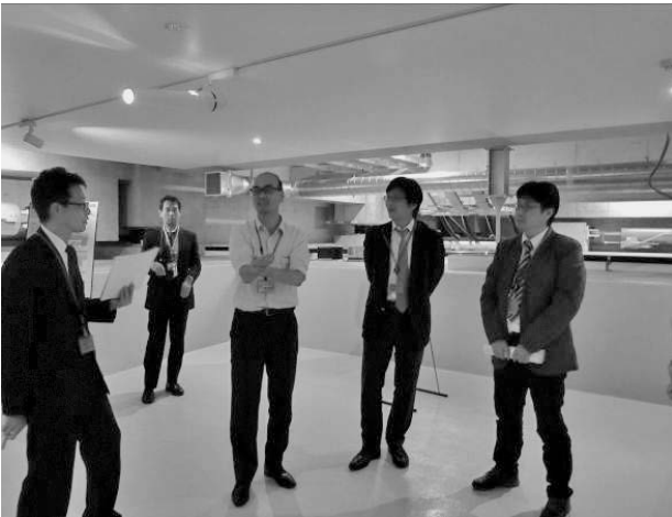
写真6 免震層内見学風景
