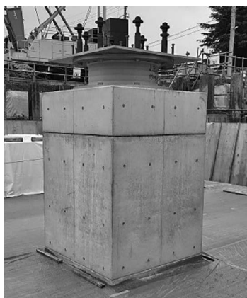
図9 柱頭部免震部材据付後
