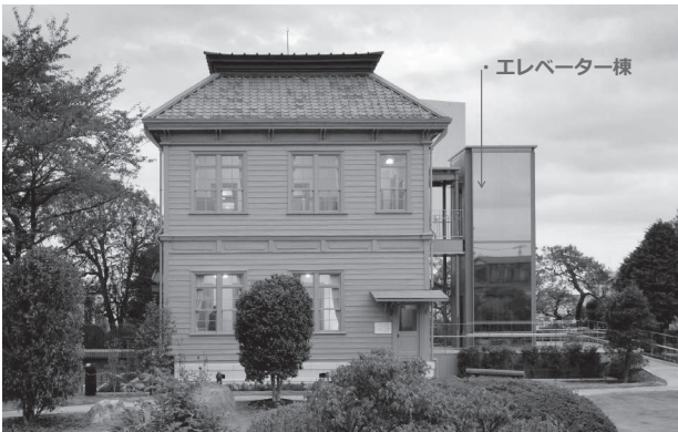
写真5 改修後の本館
