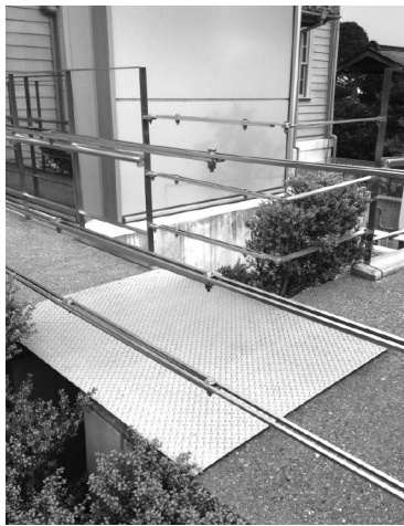
写真6 本館とスロープを繋ぐ免震エキスパンションジョイント
