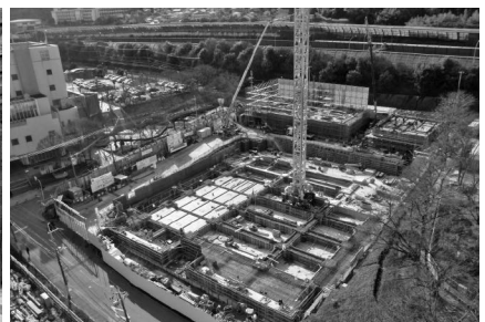
1階RC梁の施工状況
