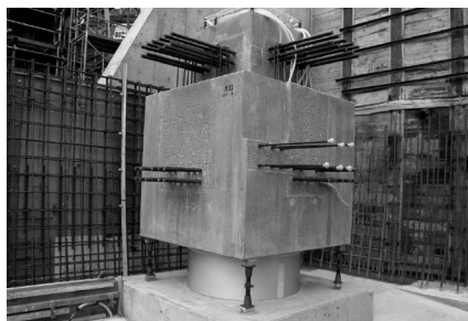
免震ブロックの設置
