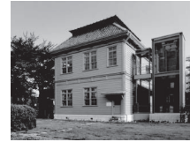
製粉ミュージアム本館
