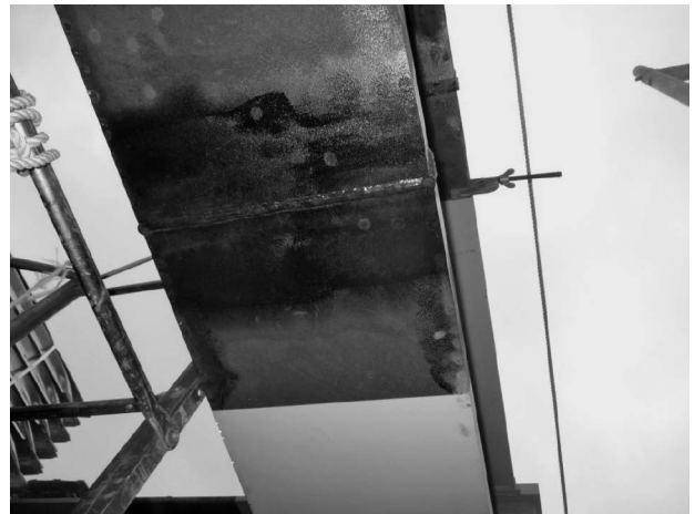
写真12 下フランジ溶接状況
