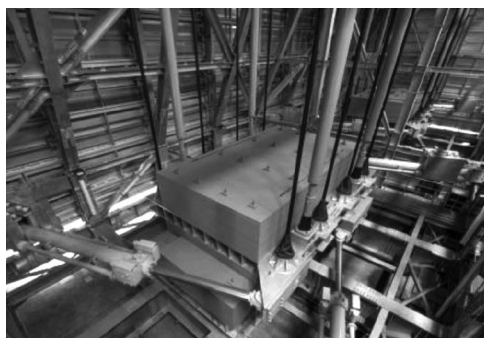
TMD内観（撮影：鹿島建設）
