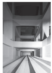
地下施設内観 （撮影：エスエス東京）
