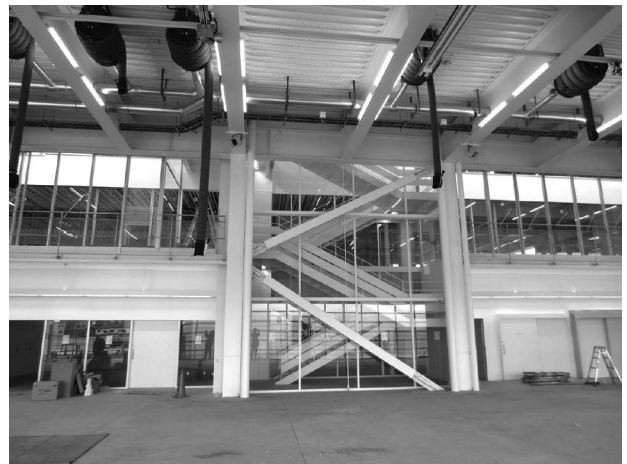
写真13 ブレース設置状況
