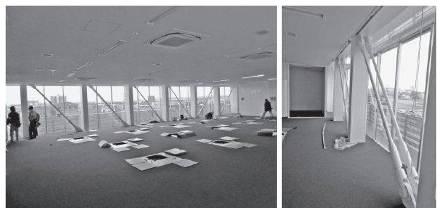
写真3 大トラス内観 (左：全景、右：ツインタイロッド)
