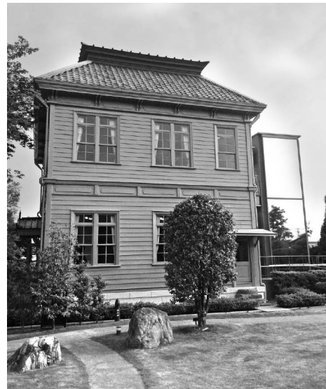
写真1 建物外観 (本館)
