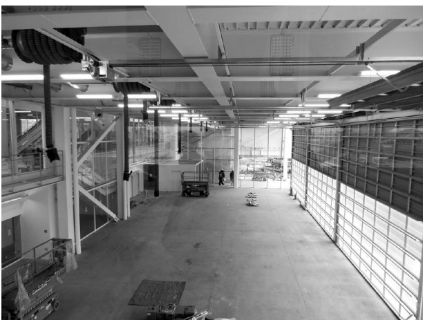
写真11 消防車庫内観
