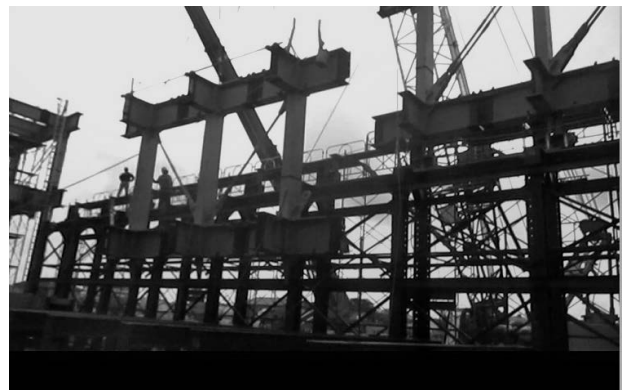
写真8 大トラス架設状況
