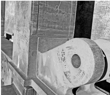
写真5 束柱と仕口の溶接部
