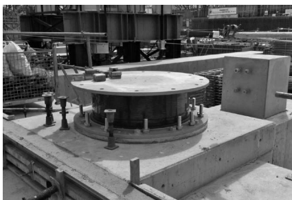
積層ゴム支承の設置
