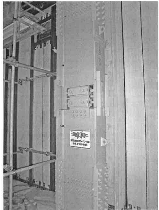
写真2 摩擦ダンパー設置状況
