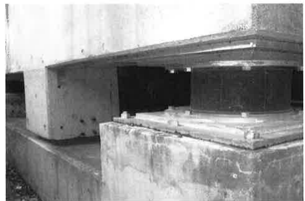
免震構造試験体 免震装置
