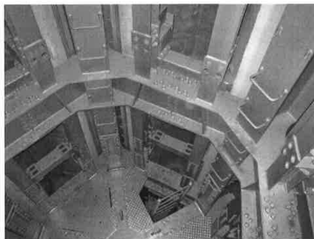
写真2 塔体内部の状況
