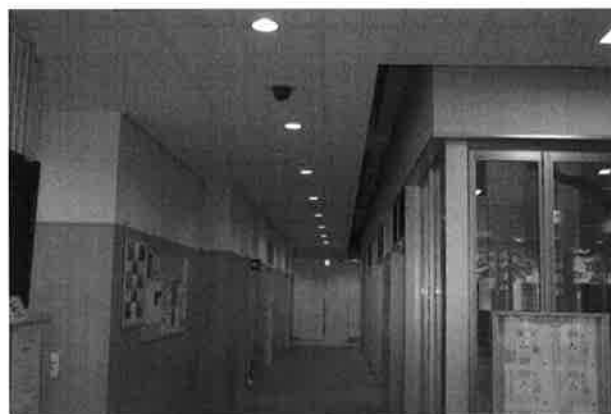
天井のクリアランス
