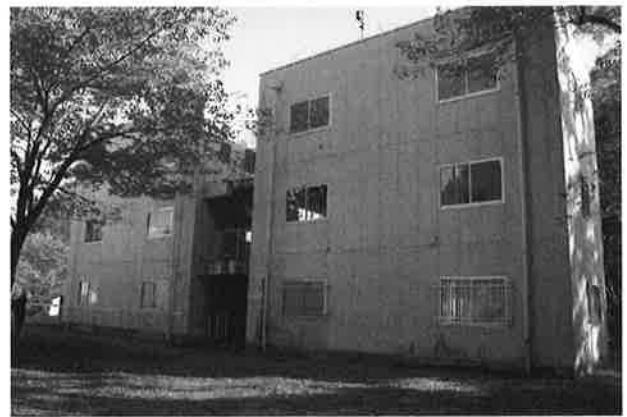
免震構造試験体（左）・耐震構造試験体（右）
