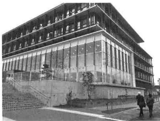
写真2 建物西面から見える擁壁
