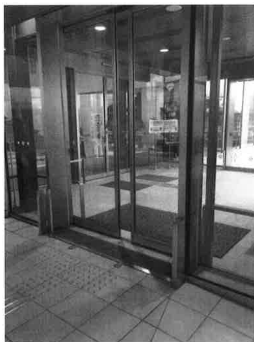
写真5 止水板取付け用枠
