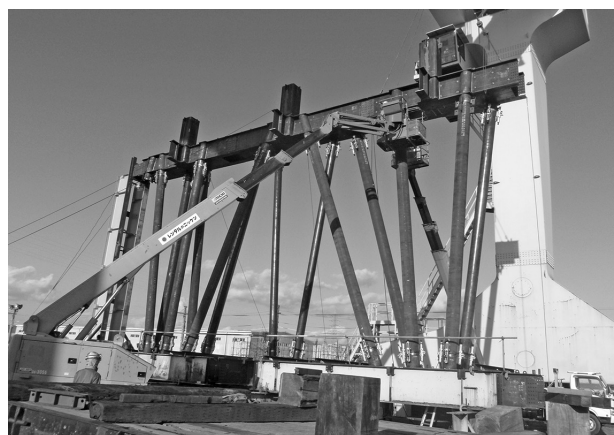
図14 鉄骨仮組検査（於エモト）
