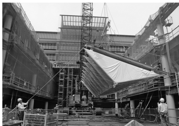
図13 フォーラム屋根建方状況
