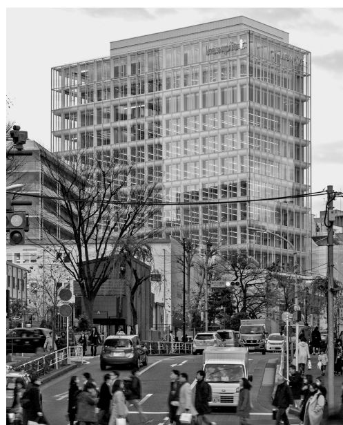
写真1 建物外観写真（美竹通り坂下より）
