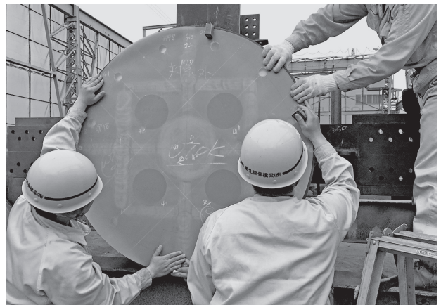
図6 免震装置ベースプレートの施工写真
