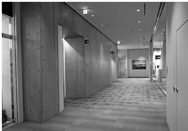
写真5 共用部のコアの耐震壁
