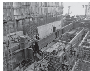
写真2 直動転がり支承周辺の擁壁施工状況
