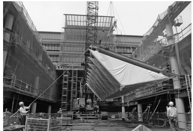
図13 フォーラム屋根建方状況
