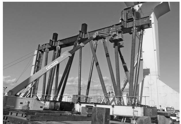
図14 鉄骨仮組検査 (於エモト)
