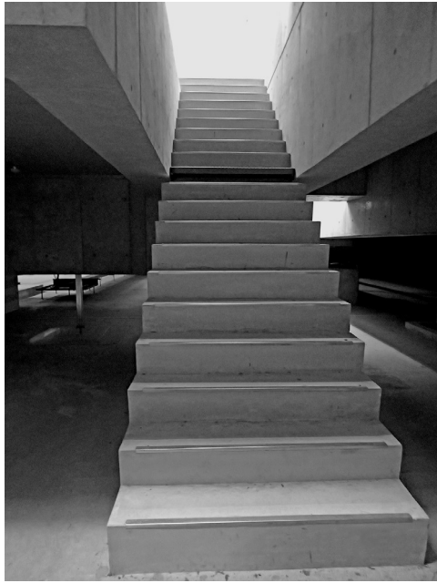
写真8 免震層への階段
