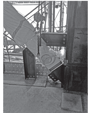
写真5 ダンパー端部施工時
