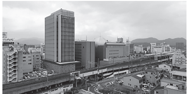
写真3 建物遠景（南西側）
