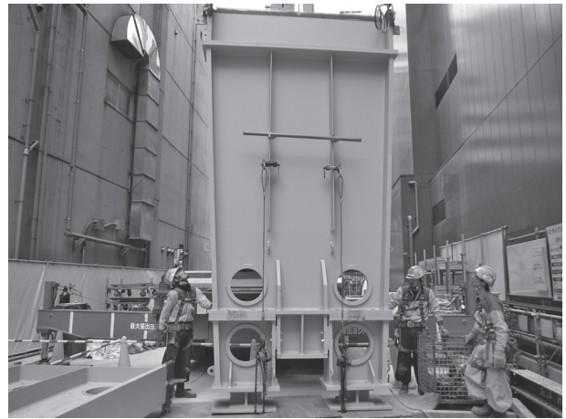
写真3 通り壁柱の建方状況
