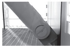
写真2 ブレース端部
