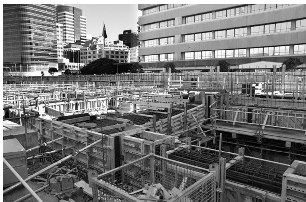
免震層上部階施工写真
