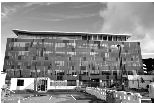
閉鎖された事務所
