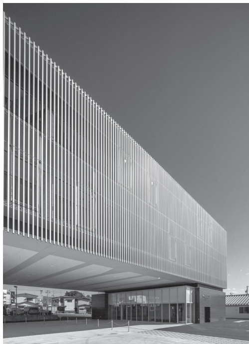
図1 消防ひろばからの事務棟外観
