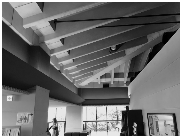
写真7 寄棟屋根隅角部見上げ
