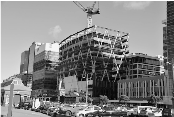
免震建物施工写真
