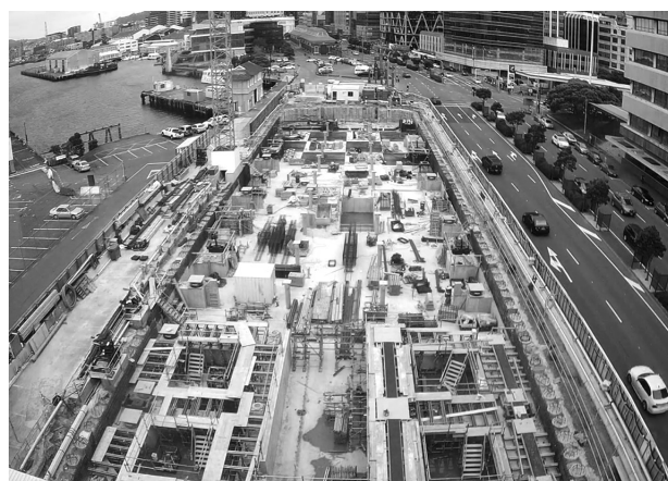
免震層施工写真
