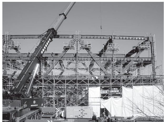
図14 鉄骨架構施工状況
