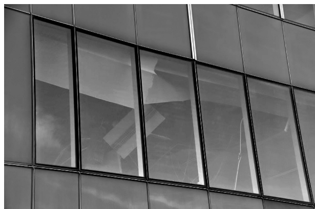
事務所内天井崩落（全フロアー）
