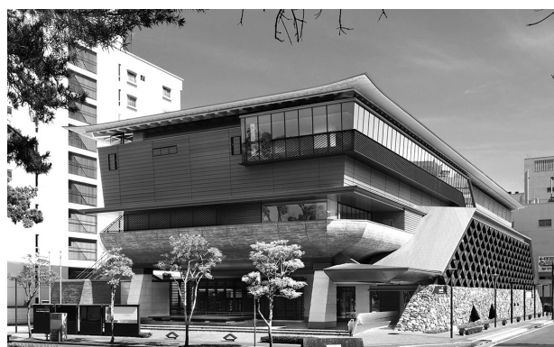
写真1 建物全景（前面道路より）
