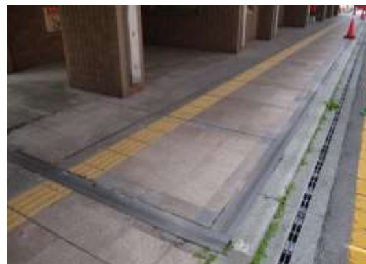
写真 13 エキスパンション部の状況(2)
