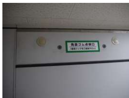
写真 24 免震ゴム点検口部分
