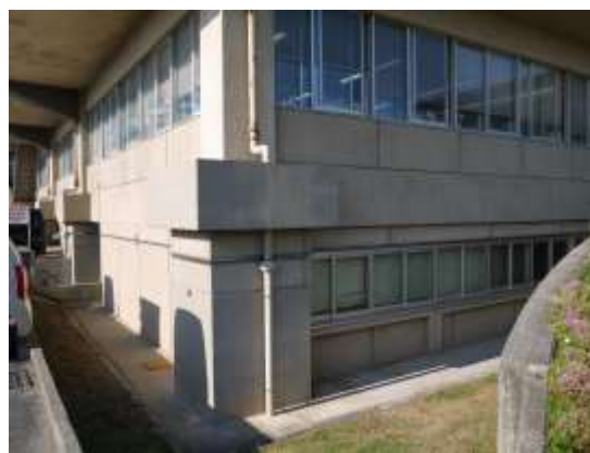
写真 22 免震層外部側（1階柱頭部）
