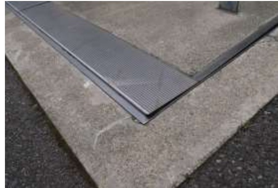
写真 19 エキスパンション部（段差あり）
