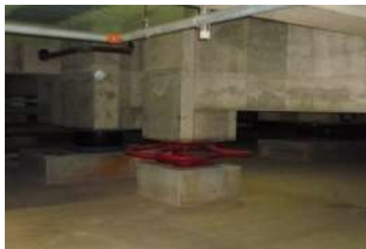
写真 11 免震層の状況
