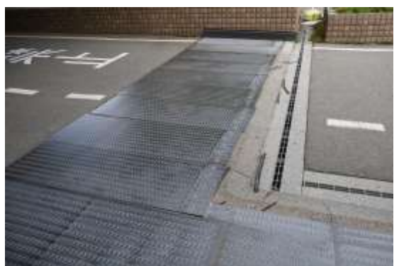
写真 12 エキスパンション部の状況(1)
