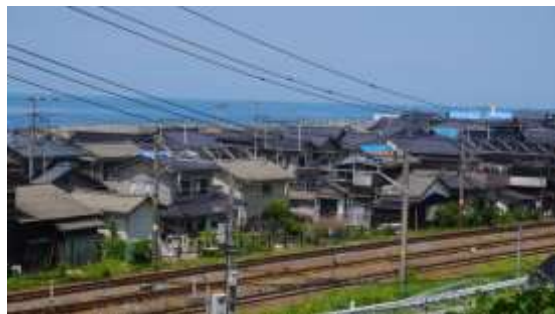
写真 9 鼠ヶ関の海辺集落（屋根瓦被害）
