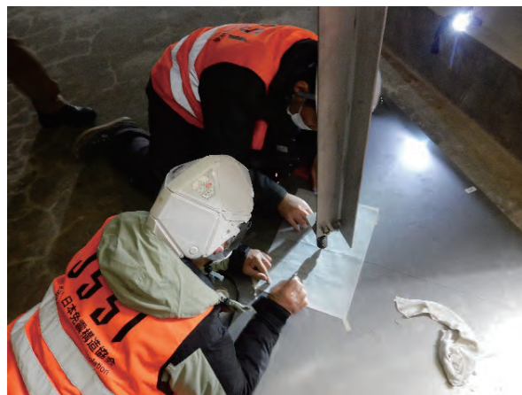
写真1 七尾市に建つ免震病院でけがき記録をトレースしている様子（2024年1月15日）
